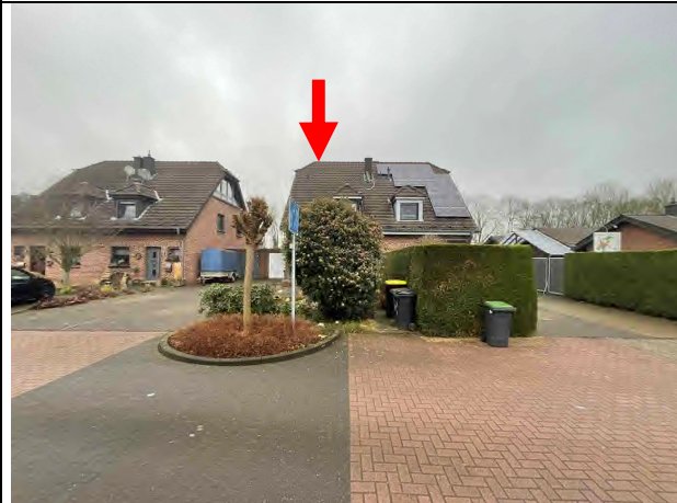
Foto 3: Blick auf das Bewertungsobjekt und die Nachbarbebauung
