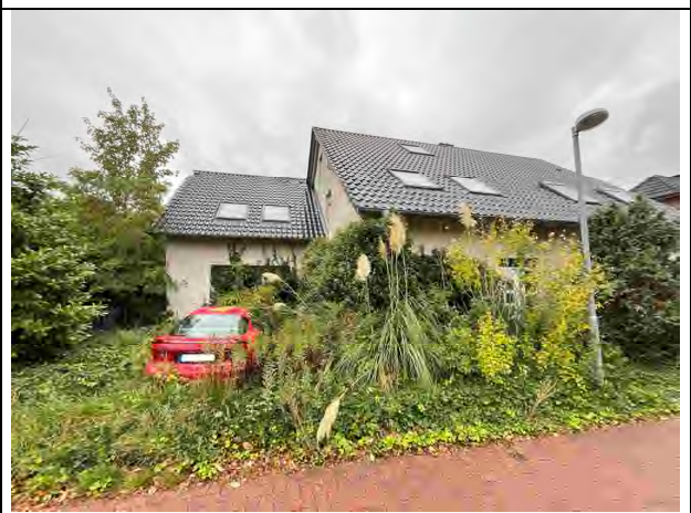
Foto 6: Blick von der Straße auf das Bewertungsobjekt
