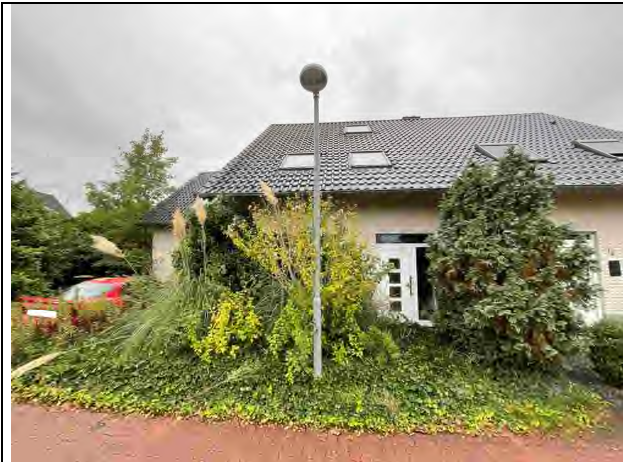
Foto 7: Blick von der Straße auf das Bewertungsobjekt
