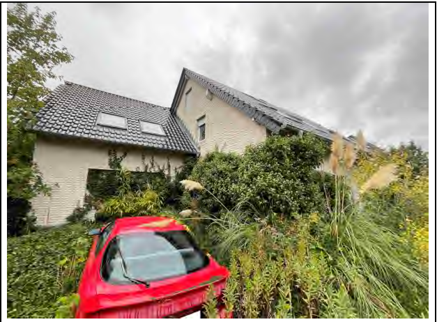
Foto 8: Blick von der Straße auf das Bewertungsobjekt
