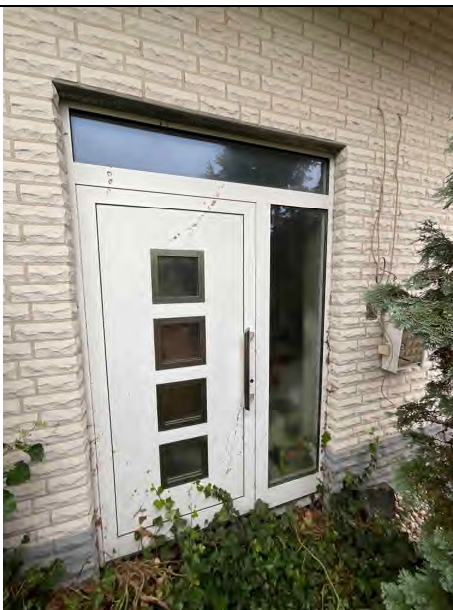
Foto 9: Blick von der Straße auf den Eingangsbereich
