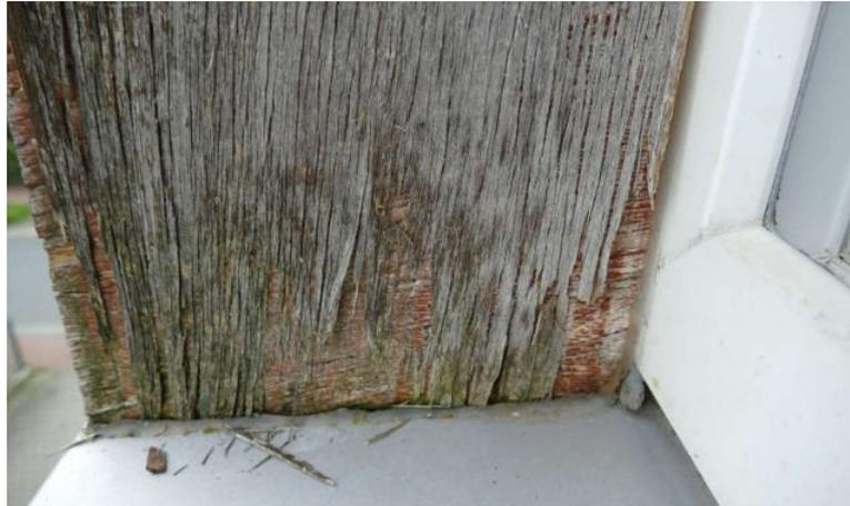
A1 | Zustand der Verkleidung (Holz) an den Fensterleibungen im Dachgeschoss (Bodenraum)
