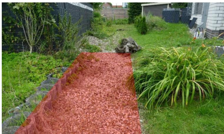
C2 | Flurstück 1931 (Kennzeichnung) als Muldensystem zu betreiben (Kiesbeet), siehe Baulastenblatt Nr. 1252 – siehe Abschnitt 1.2 „Hinweise“ sowie Anlage I
