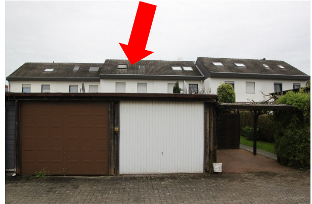
Rückwärtige Ansicht Wohnhaus / Nebengebäude im Vordergrund
