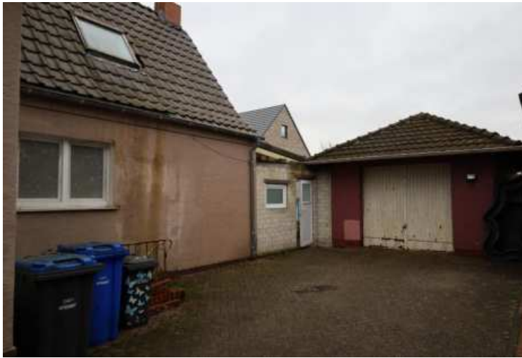
Ansicht auf die Garage und den Seiteneingang
