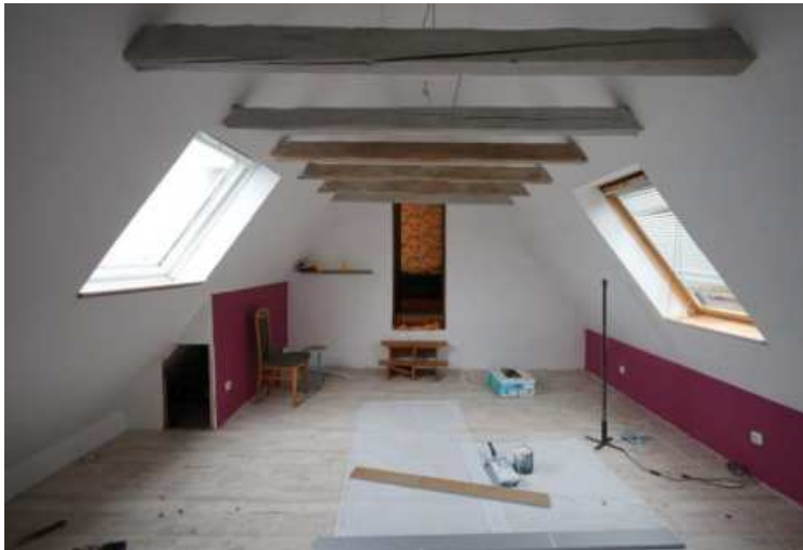
Zimmer im DG des Anbaus an der Nordseite
