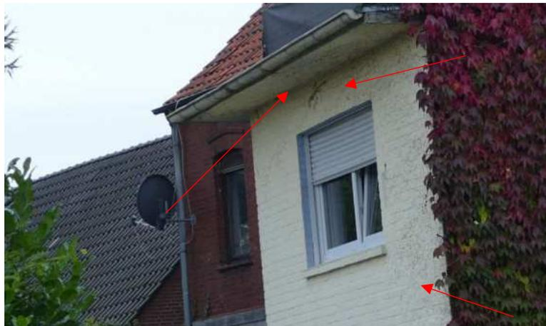
A10 Zustand der östlichen Fassade – Haftwurzeln am Dachüberstand und am Verblendmauerwerk (gestrichen)
