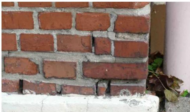
A12 Zustand der Verblendfassade: Verfugungen fehlen partiell
