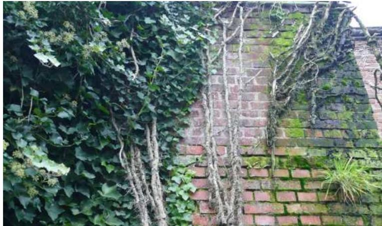
B1 Zustand des Mauerwerks an der nördlichen Gebäudefassade: partiell erhebliche Durchfeuchtungen, tlw. fehlende Mauerfugen
