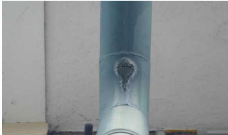
A4 Fallrohr mit Undichtigkeit
