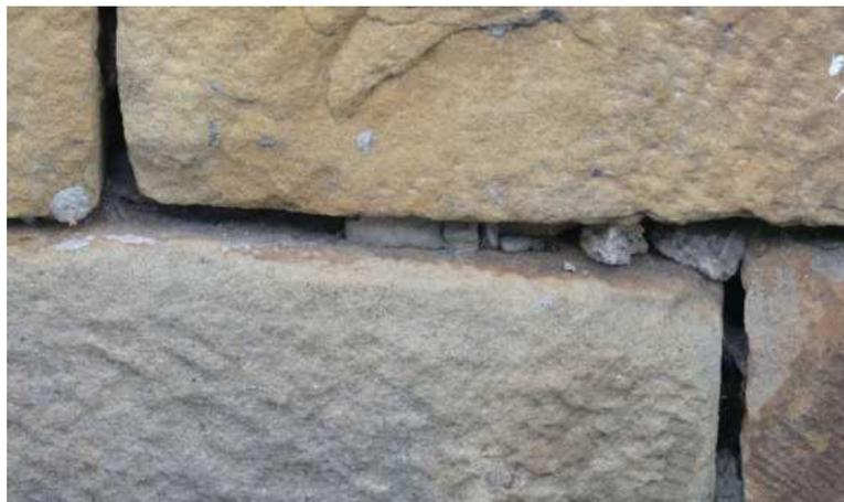
A11 Zustand des Sockelmauerwerks: Verfugungen fehlen partiell
