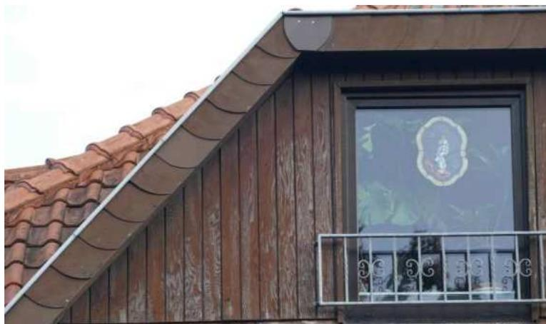
A6 Zustand des Anstrichs der Holzverkleidung am Dachaufbau vermutlich durch langjährige Witterungseinflüsse erfolgt
