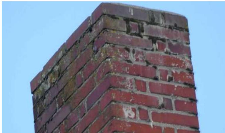
A1 Zustand des Mauerwerks am Schornsteinkopf
