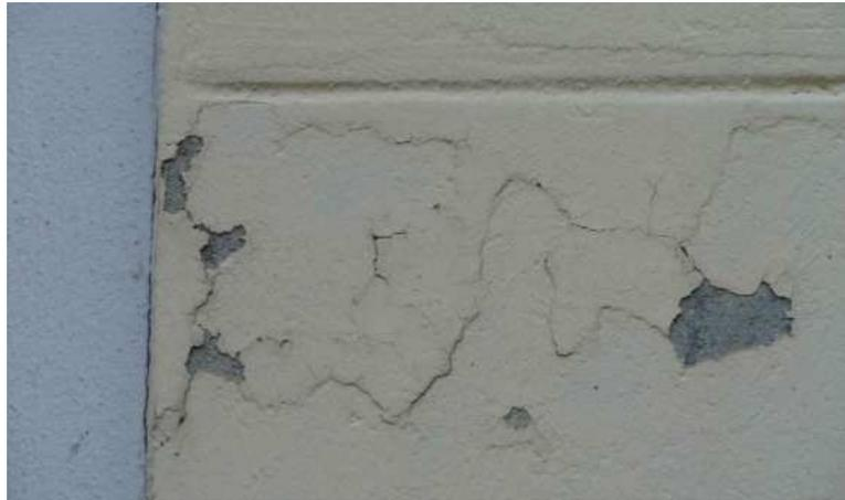
A10 Zustand des Anstrichs, vermutlich durch Witterungseinflüsse entstanden
