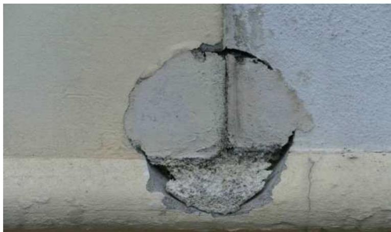
A9 Zustand Fassade: Abplatzung von Putz
