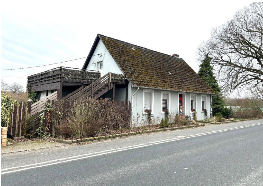
Wohnhaus von Nordosten
