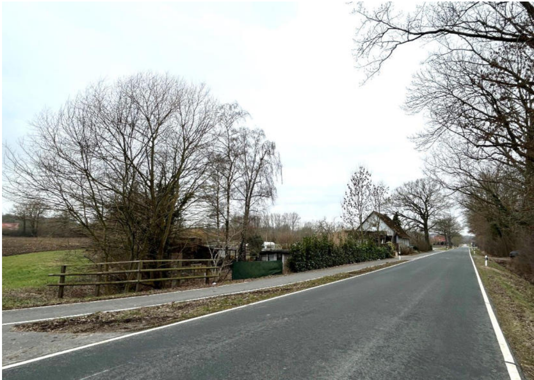
Gesamtansicht von Nordosten
