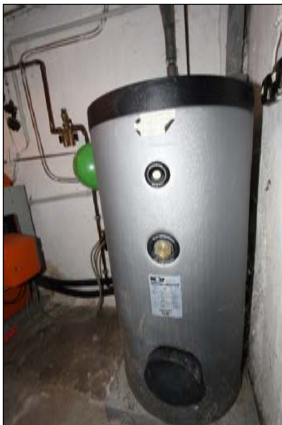
Warmwasserpufferspeicher
