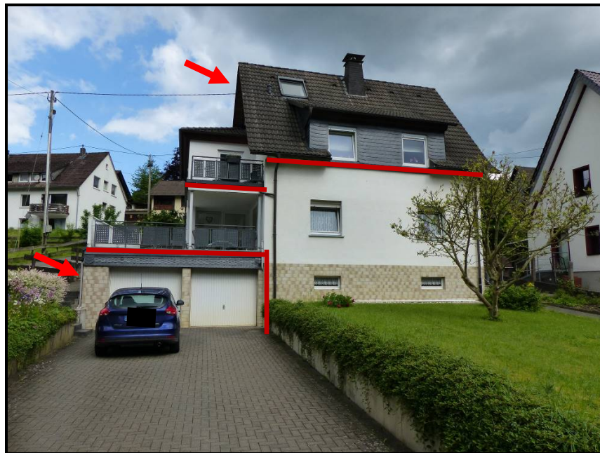
Foto Nr. 1 Straßenansicht des Zweifamilienwohnhauses In der Petmecke 38, 38a aus südlicher Richtung (Lage ETW Nr. 2).
