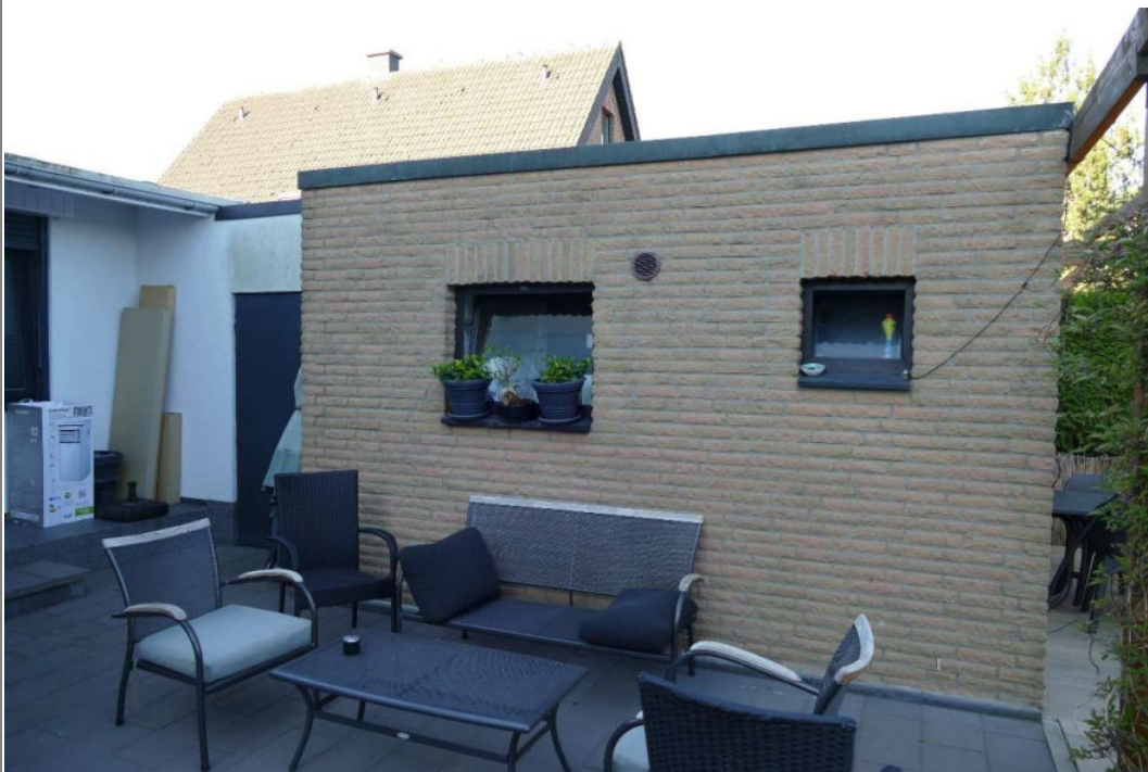
7 | Ansicht des Mehrzweckraums „Windfang, Abstellraum, HWR und WC“
