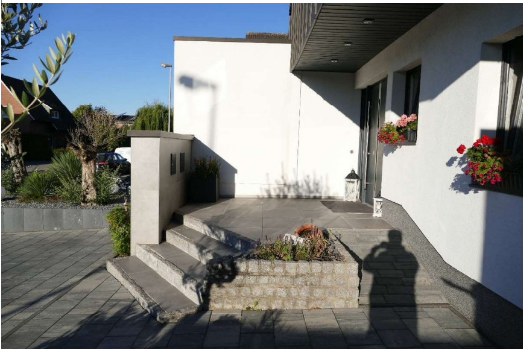
4 | Ansicht der Treppenanlage zum Eingang „Hauptwohnung“
