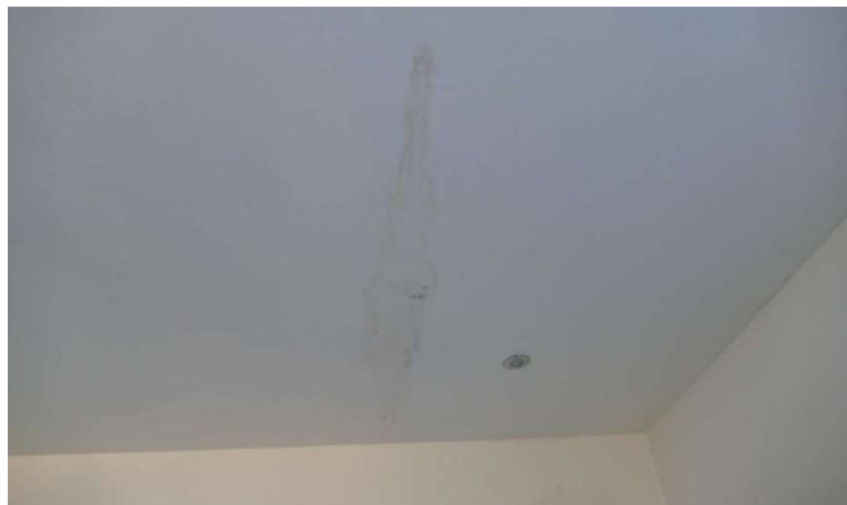
C6 | Lt. Gutachten des Sachverständigen Feldhaus: Durchfeuchtungerscheinungen im Deckenbereich des Aufenthaltsraums unterhalb des Balkons
