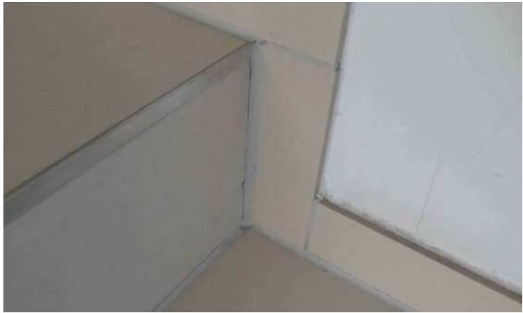
B1 Wartungsfugen partiell beschädigt
