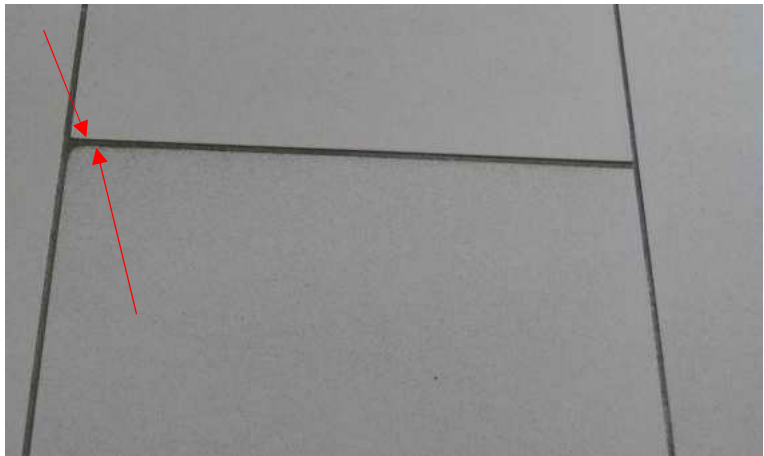
B2 Fliesen in Eigenleistung verlegt – tlw. unregelmäßiges Fugenbild
