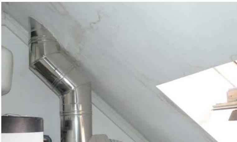
B18 Feuchtigkeitsschäden im Heizungsraum (DG)
