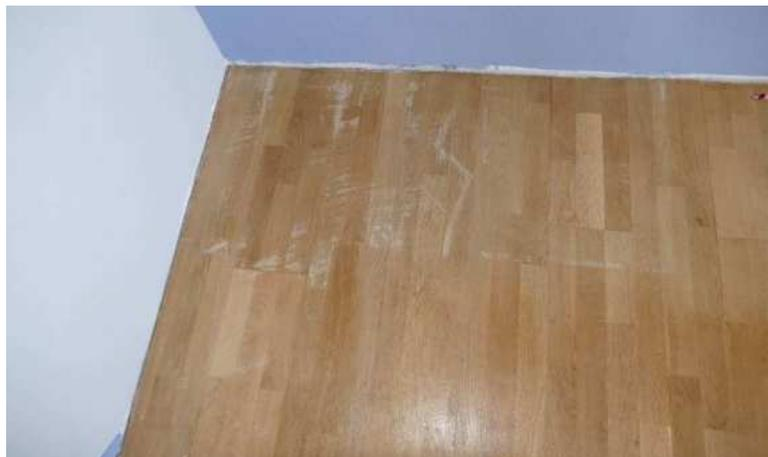
B8 Zustand der Bodenbeläge im DG – partiell beschädigt
