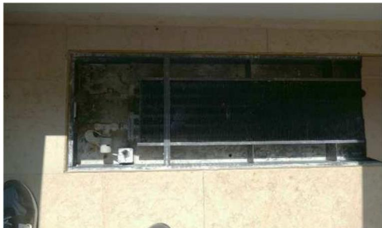
B6 fehlendes Rollgitter über Konvektor-Schacht im EG
