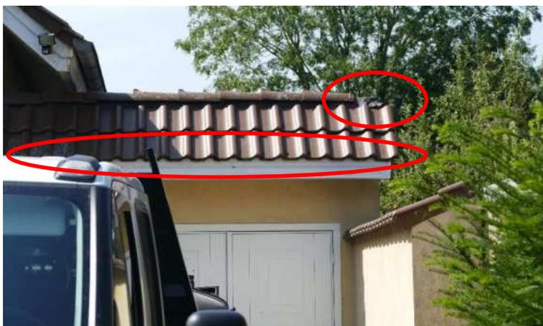
C4 fehlender Firstziegel und fehlende Entwässerung (Rinne und Fallrohr); weitere Entwässerung unbekannt
