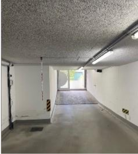
Bild 37: Tiefgaragenein- und ausfahrt
