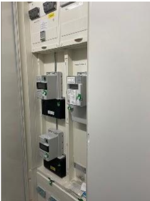
Bild 35: Stromzähler
