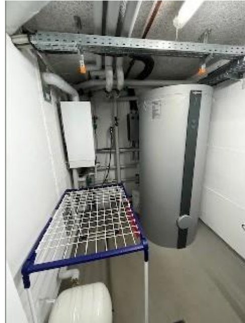
Bild 34: Warmwasserspeicher
