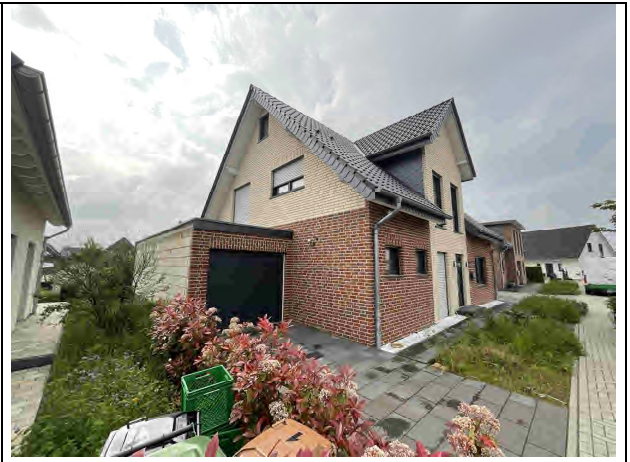
Foto 2: Blick von der Straße auf das Bewertungsobjekt
