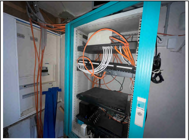
Foto 14: Elektroinstallation im EG
