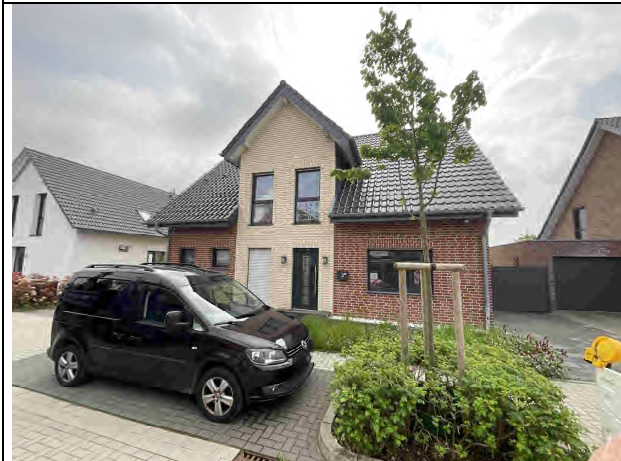
Foto 3: Blick von der Straße auf das Bewertungsobjekt
