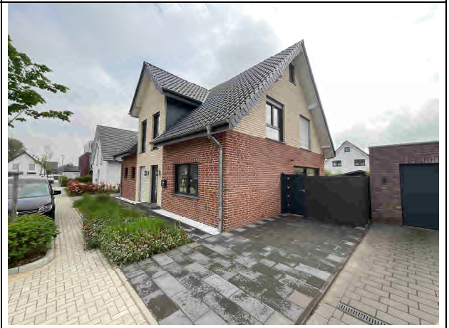
Foto 4: Blick von der Straße auf das Bewertungsobjekt
