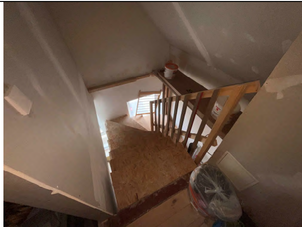
Foto 19: Treppe vom Dachgeschoss zum Spitzboden
