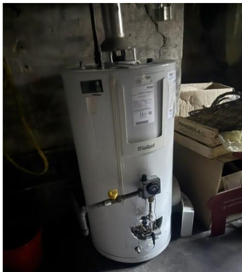
Bild 7: Warmwasserspeicher KG
