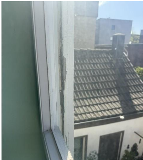
Bild 11: Holzfenster mit Einfachverglasung I.OG
