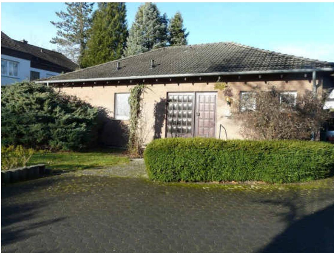
Ansicht von Südosten
