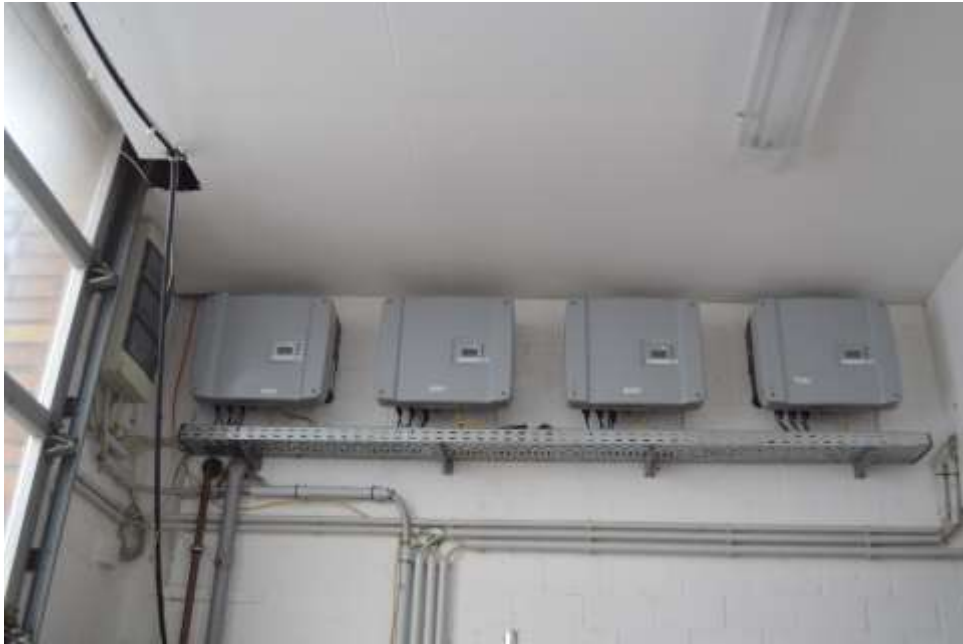
Bild 19: Anschlüsse Photovoltaikanlage(n)
