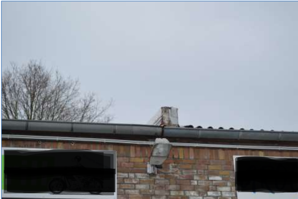
Bild 9: Brandwand zwischen Haus Nr. 2 und Haus Nr. 2 a
