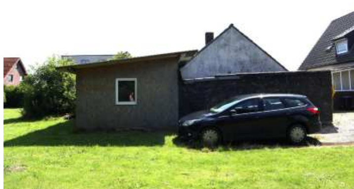
Foto 6: Schuppenanbau, Schuppen, Garage, Westansicht
