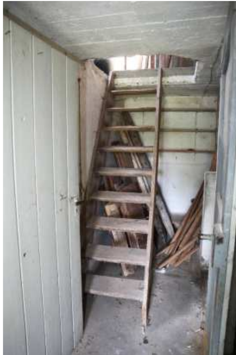
Foto 20: Schuppen Treppe zum Dachboden
