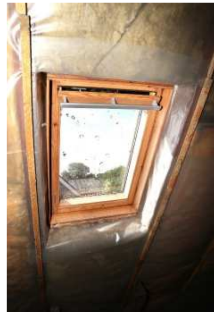
Foto 15: Dachfenster im Dachboden
