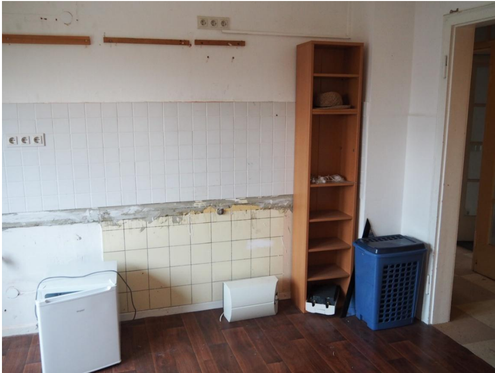
Foto 7: Zimmer mit Küchenanschluss im Dachgeschoss
