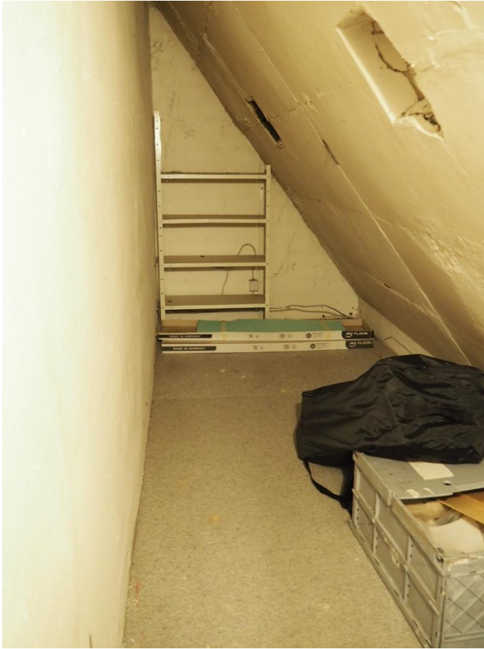
Foto 9: Abstellraum im Dachgeschoss
