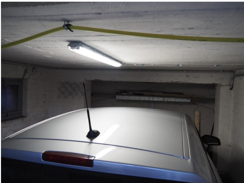
Foto 4: PKW-Garage im Kellergeschoss
