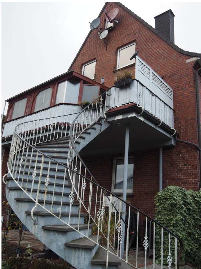
Foto 2: Gartenansicht Wohnhaus mit Terrasse und Balkonanlage
