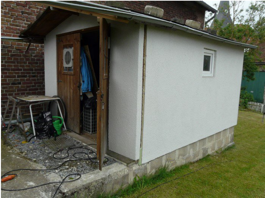
Ansicht von Norden (Geräteschuppen 1)
