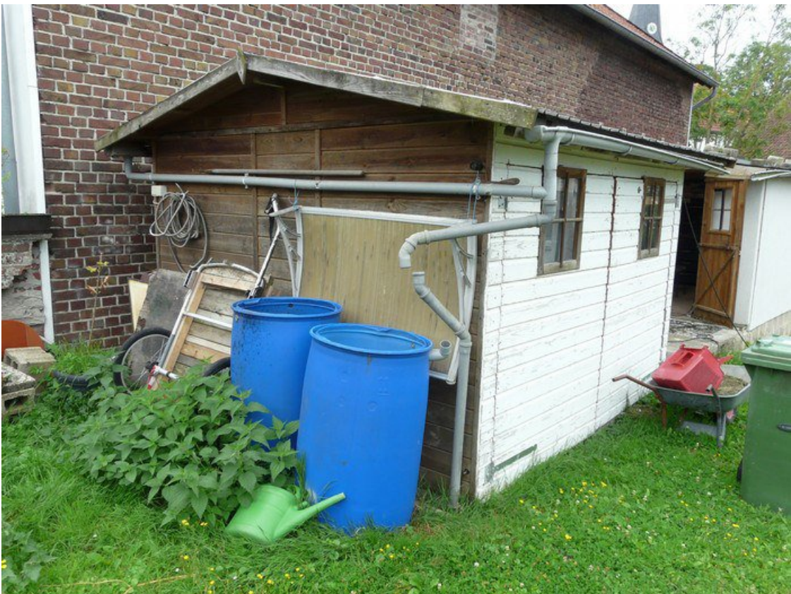
Ansicht von Norden (Geräteschuppen 2)
