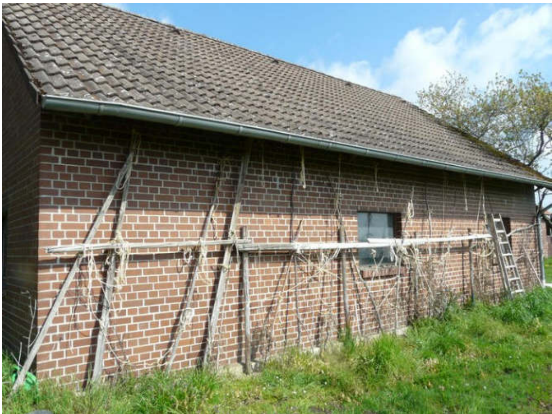
Ansicht von Süden (neue Remise)
