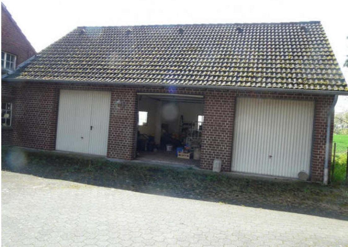
Ansicht von Nordwesten (neue Remise)
