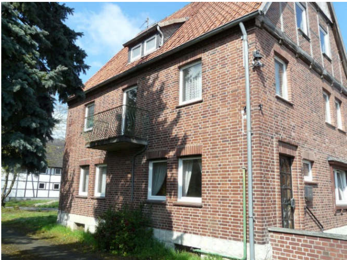
Ansicht von Südosten (Einfamilienhaus)
