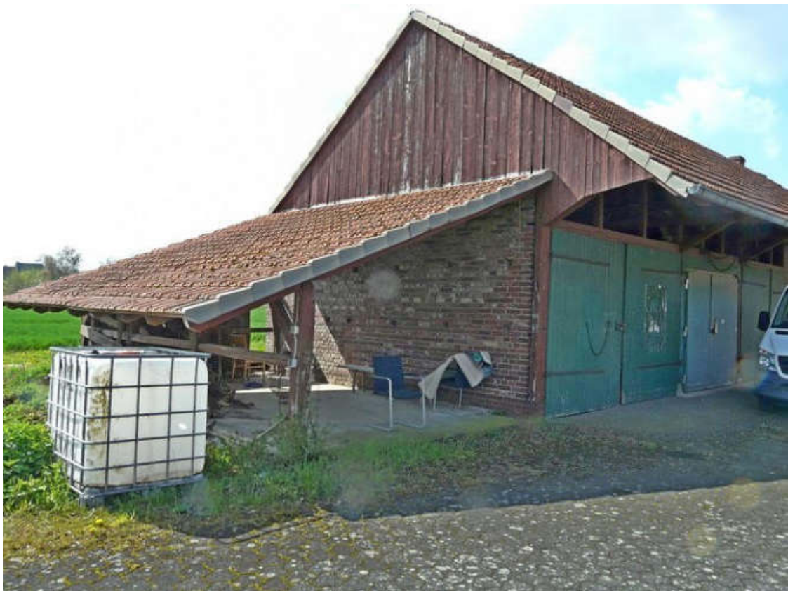
Ansicht von Nordosten (alte Remise)
