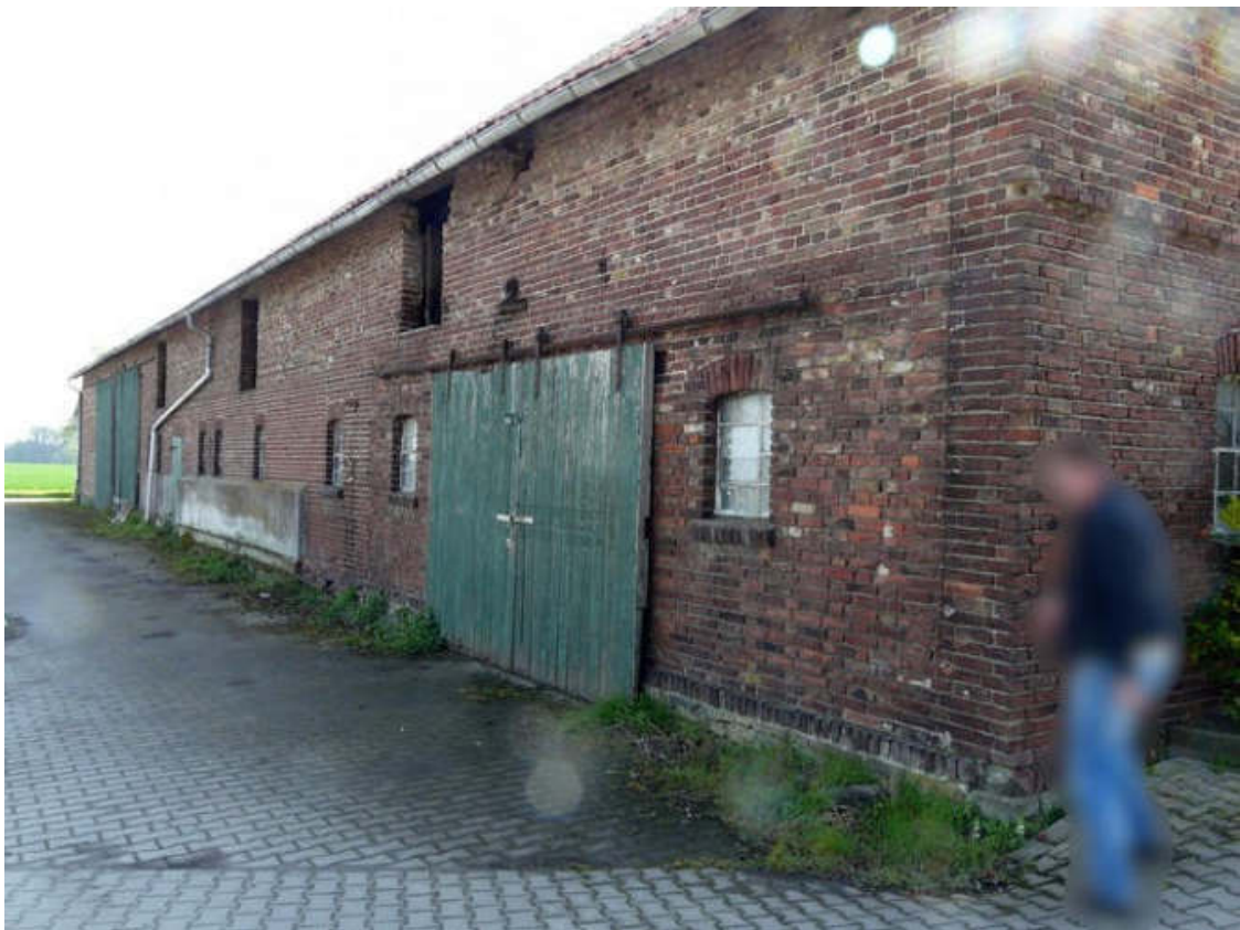
Ansicht von Westen (ehem. Viehhaus)
