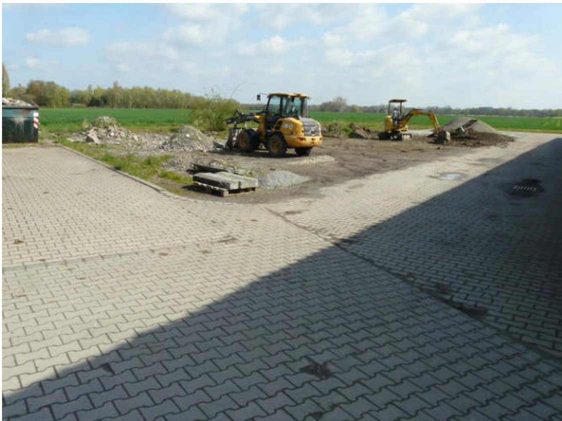
Blick in Richtung Norden (Lagerfläche im Freien)
