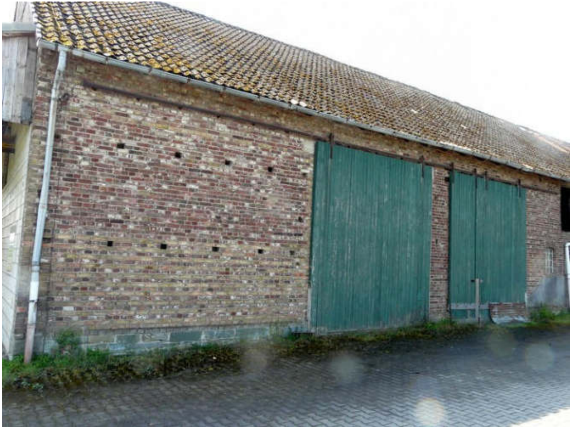
Teilansicht von Norden (ehem. Viehhaus)
