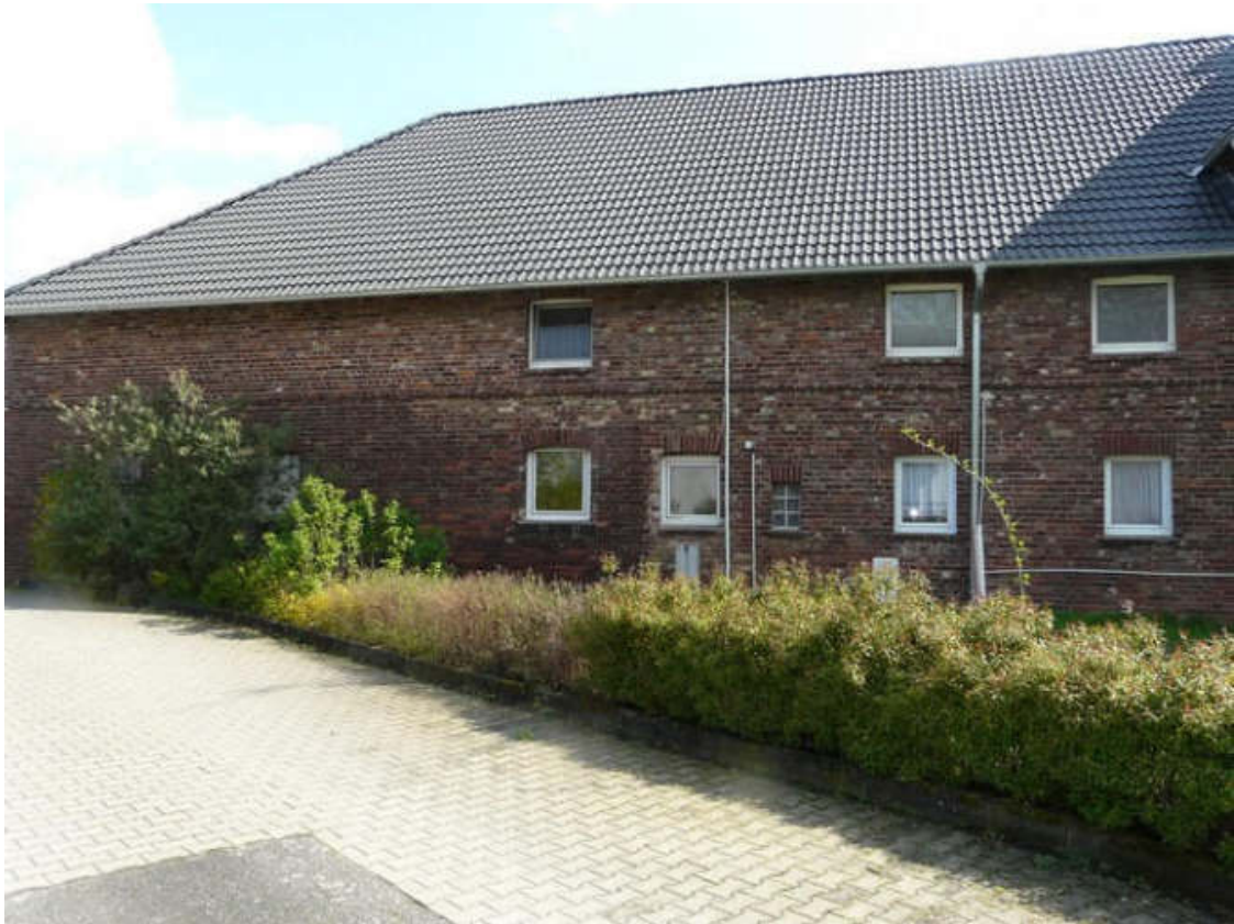
Ansicht von Südwesten (ehem. Viehhaus, Zwischenbau)
