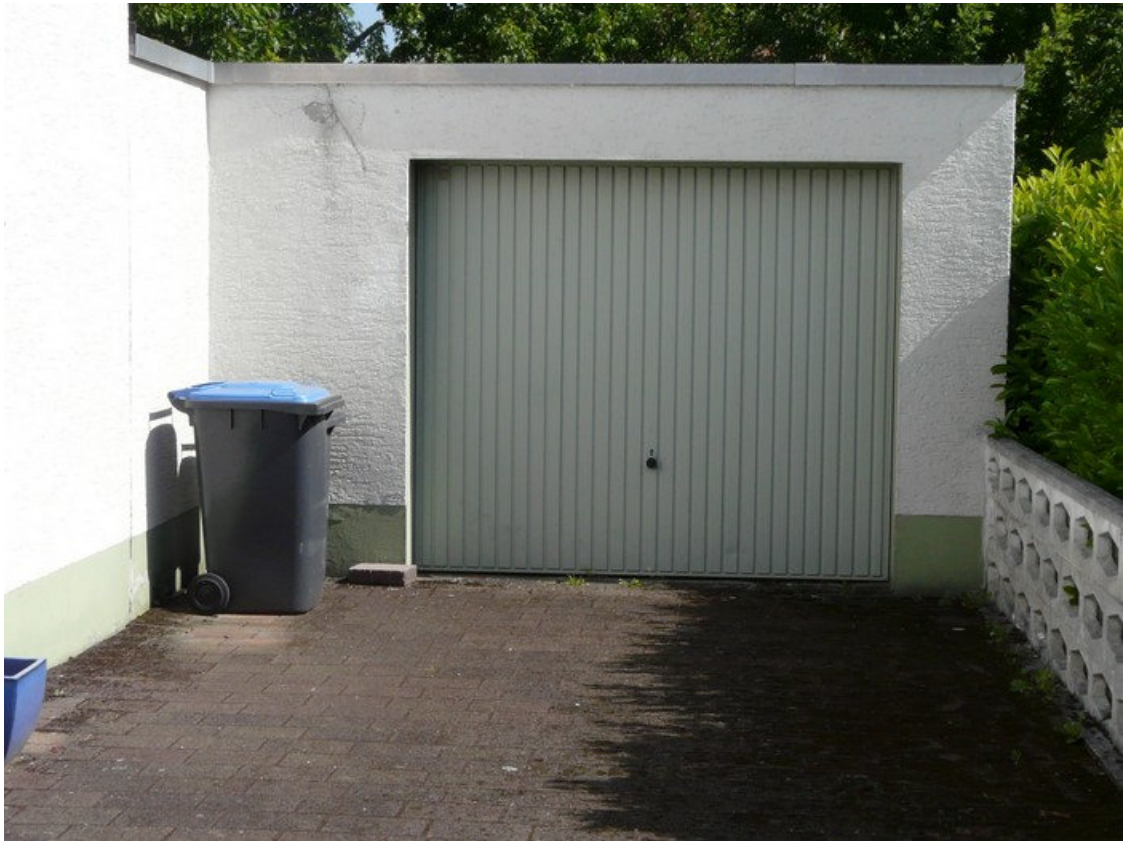
Ansicht von Südwesten (Garage)
