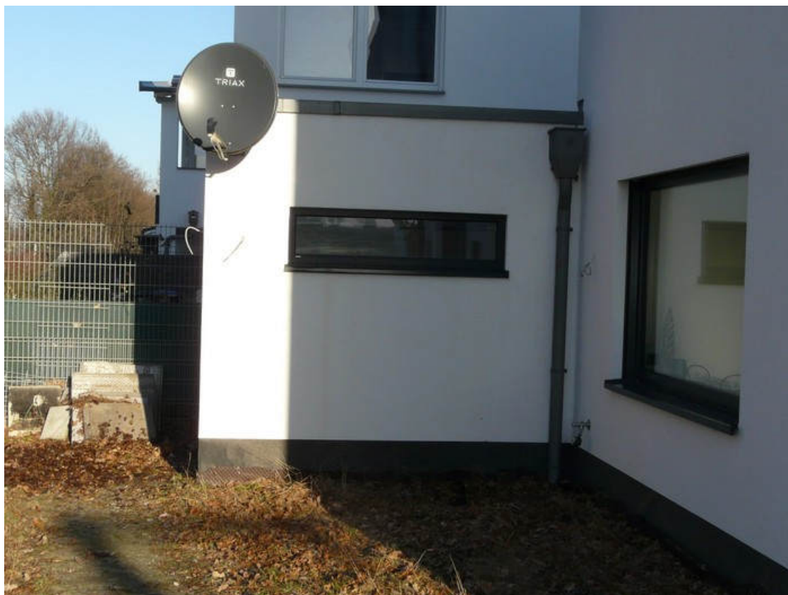
Ansicht von Südosten (Garage)
