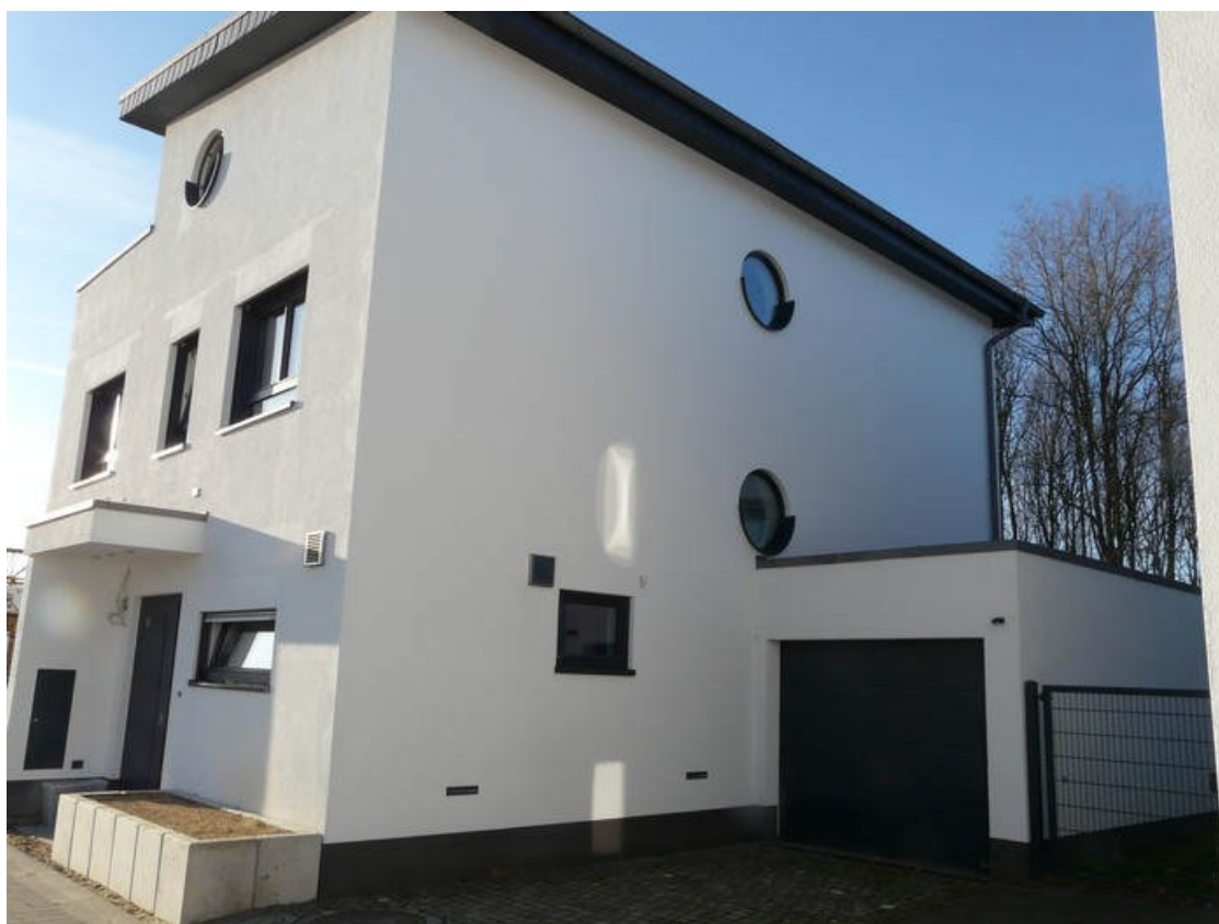
Ansicht von Norden
