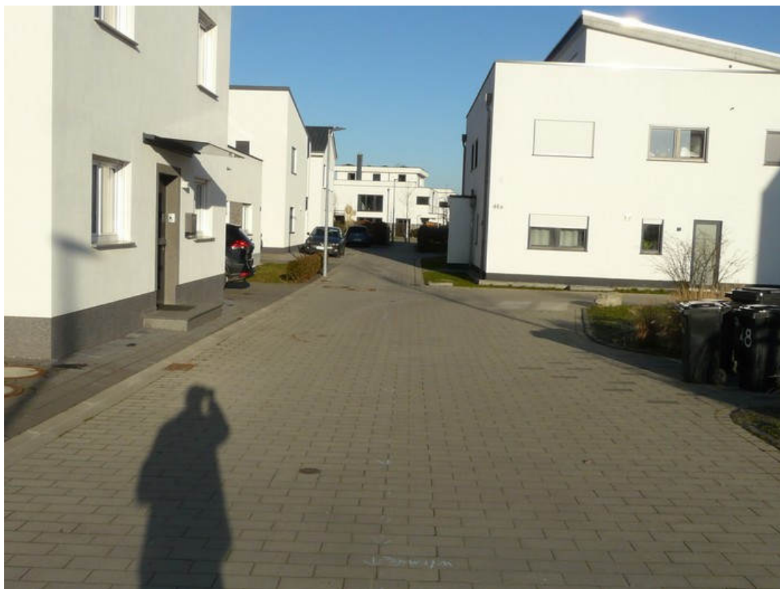
Umgebung in Richtung Nordwesten
