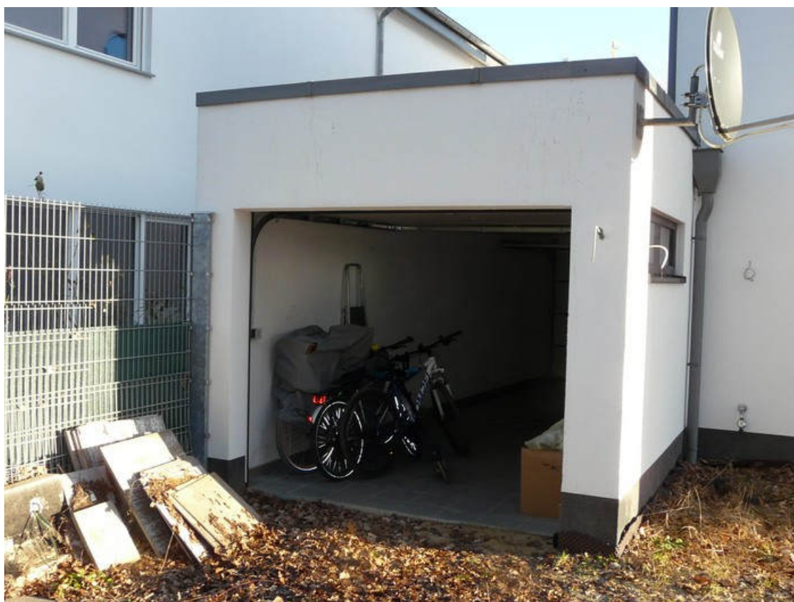
Ansicht von Südwesten (Garage)
