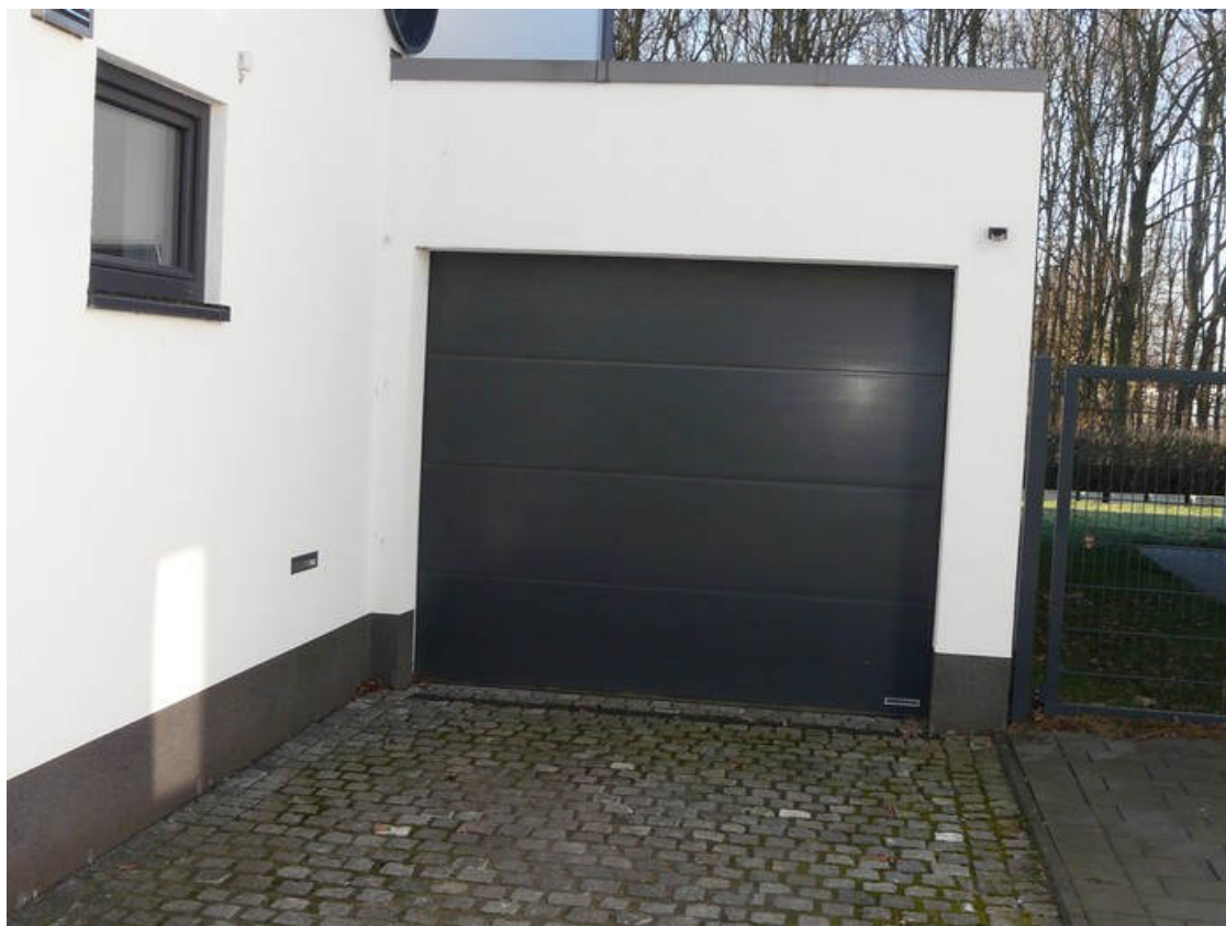
Ansicht von Südosten (Garage)
