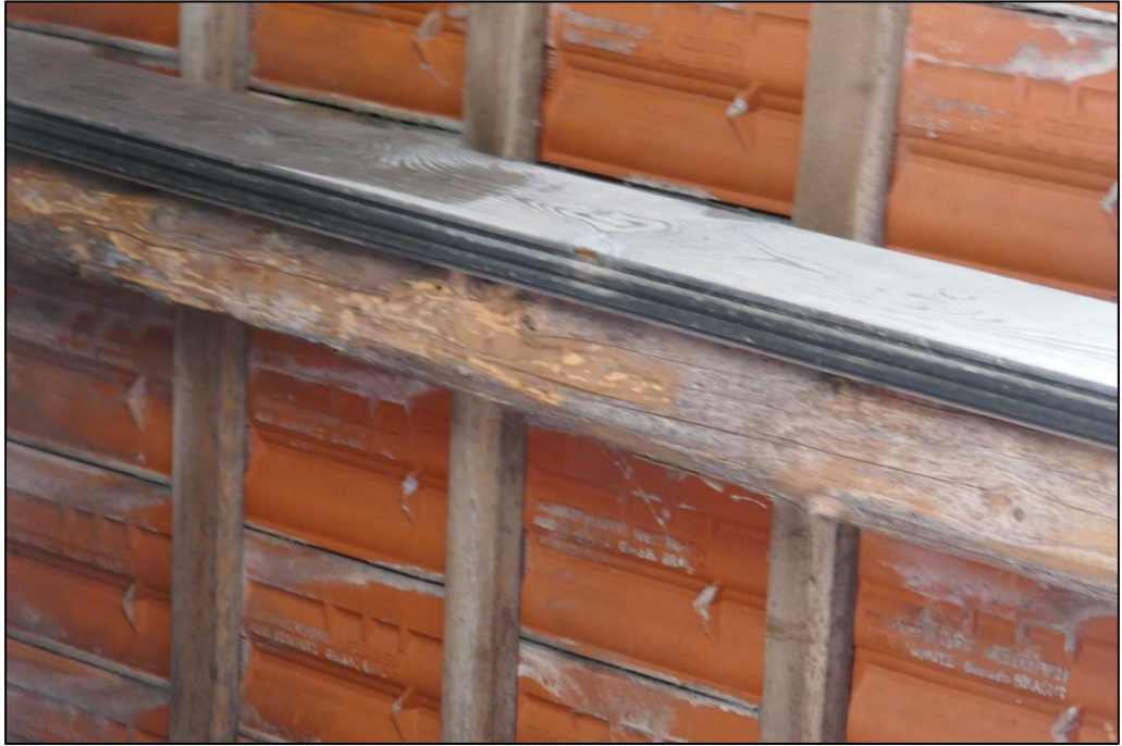
Insektenbefall Dachstuhl
