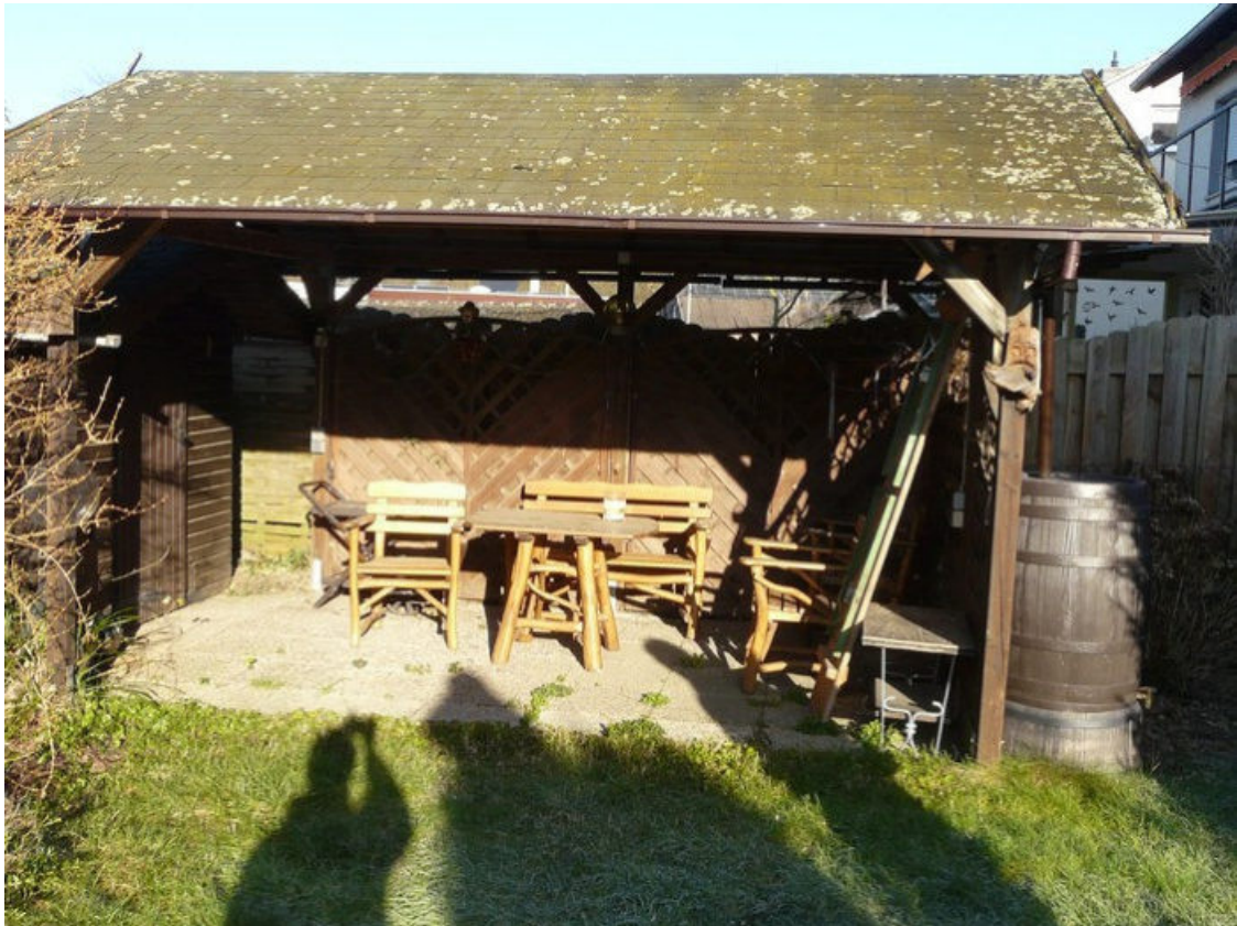
Ansicht von Süden (Außenanlagen, Freisitz)
