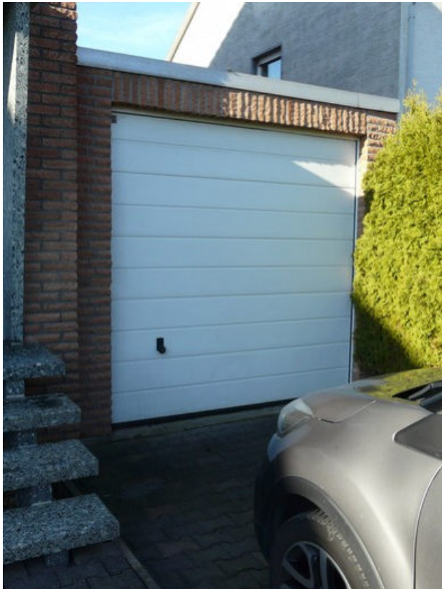
Ansicht von Osten (Garage Nord)
