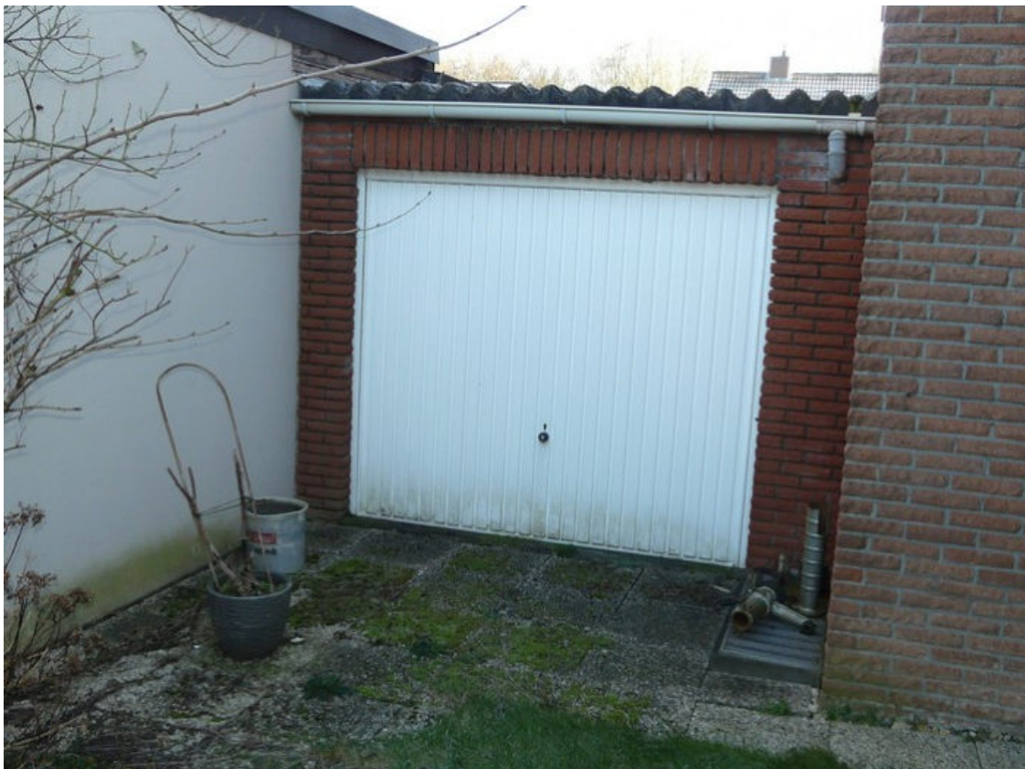
Ansicht von Westen (Garage Nord)
