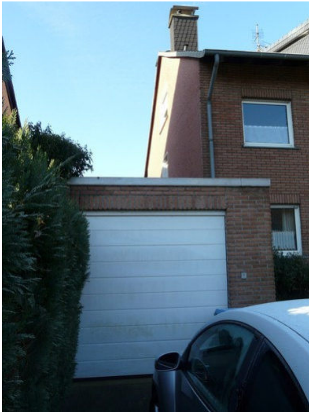
Ansicht von Osten (Garage Süd)
