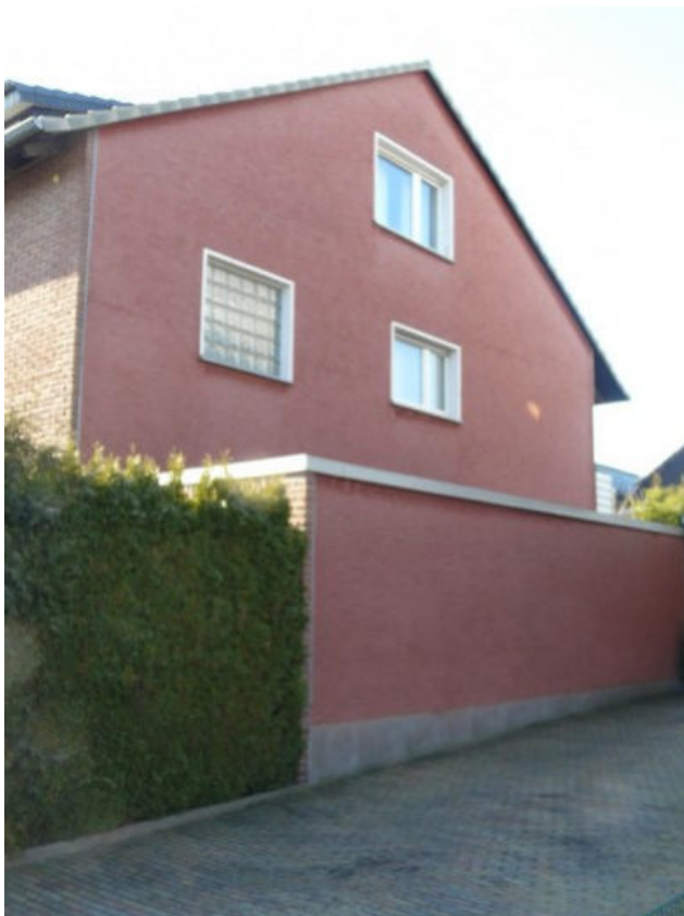
Ansicht von Nordosten (mit Garage Nord)
