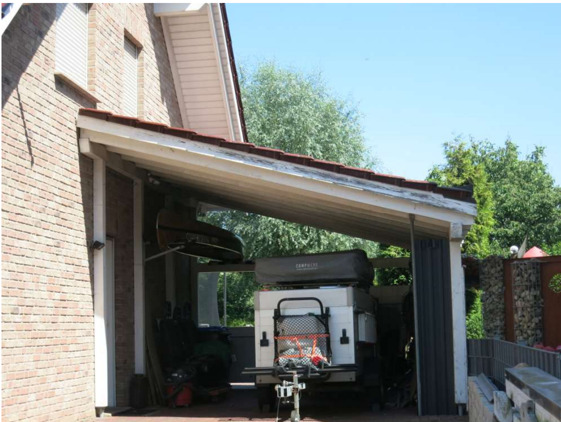
Außenansichten, (Rissbildung im Sturzbereich, Holzkonstruktion Carport in Teilen erneuerungsbedürftig)
