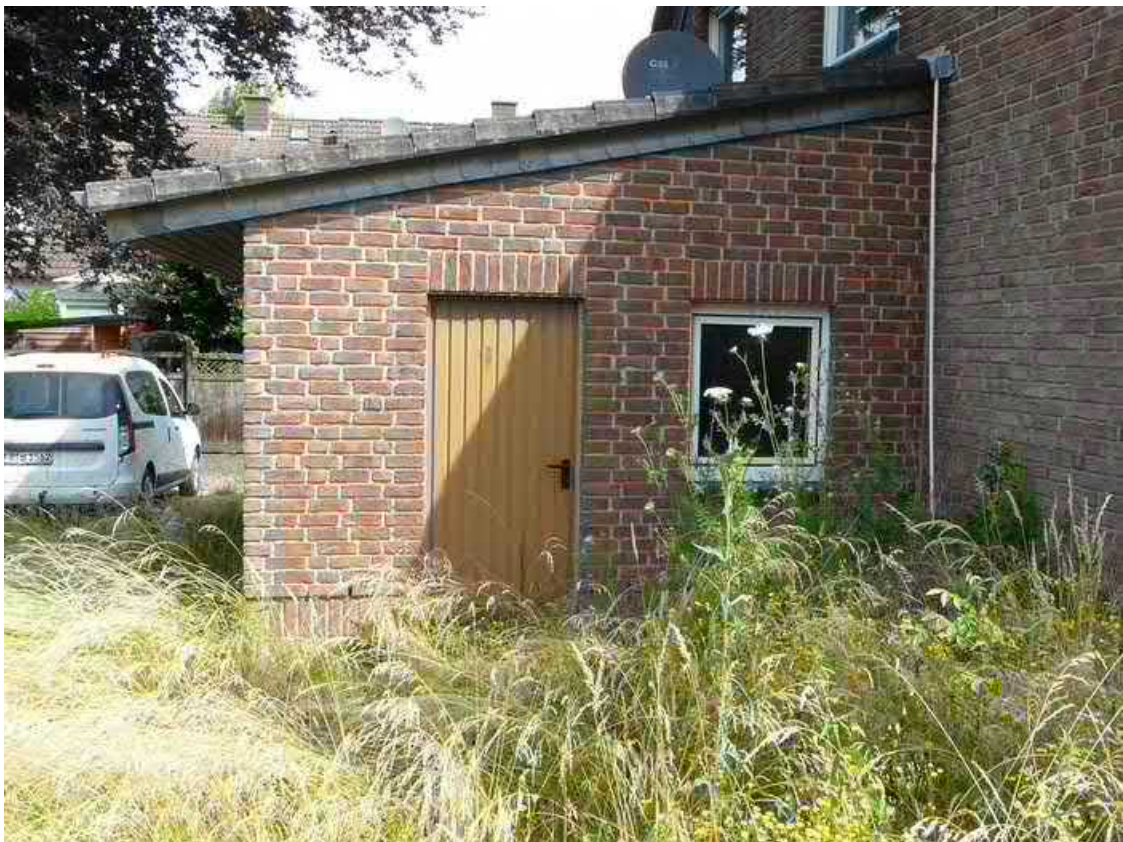
Ansicht von Süden (Garage)
