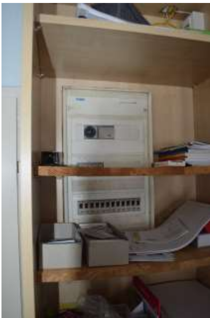
Bild 15: Elektrounterverteilung Gewerbe
