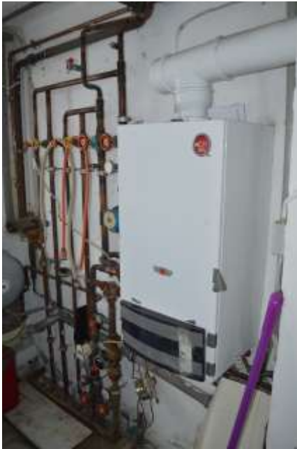
Bild 17: Gascentralheizung
