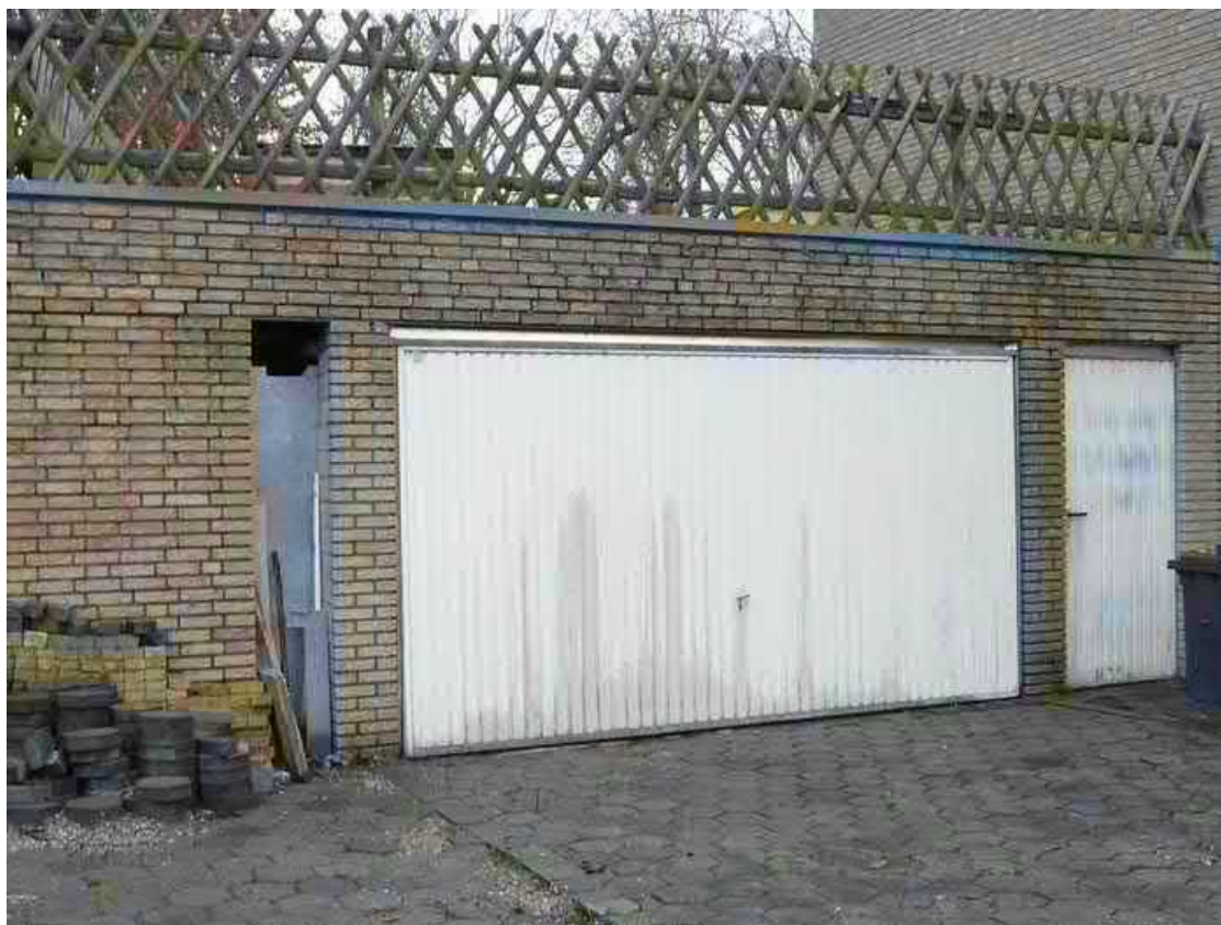
Ansicht von Süden (Doppelgarage)
