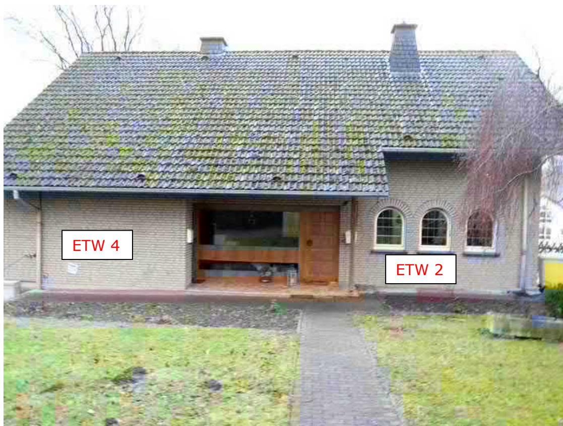
Ansicht von Norden
