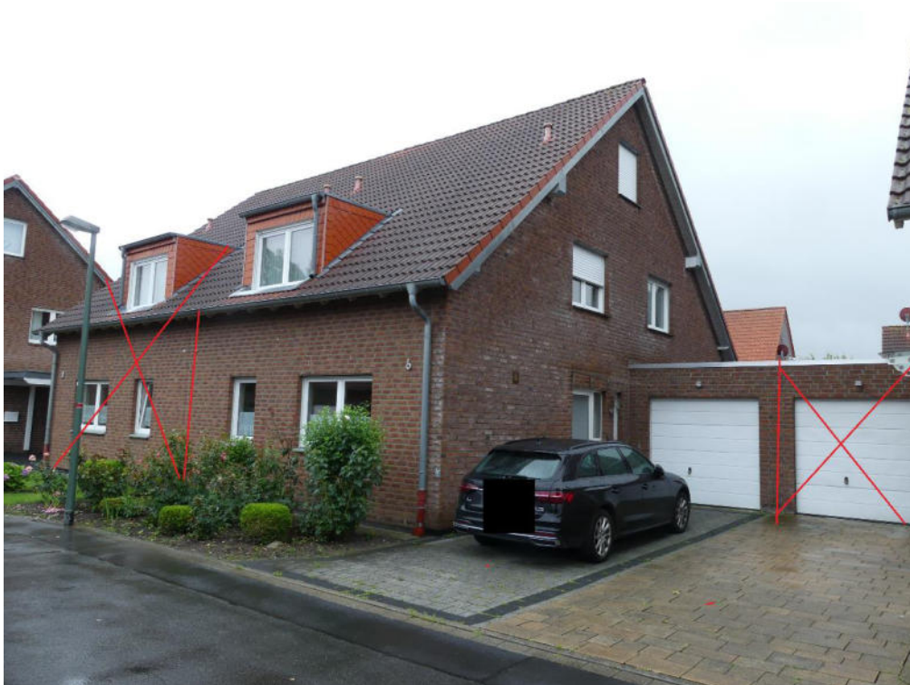
Ansicht von der Straße / Nord- und Westseite
