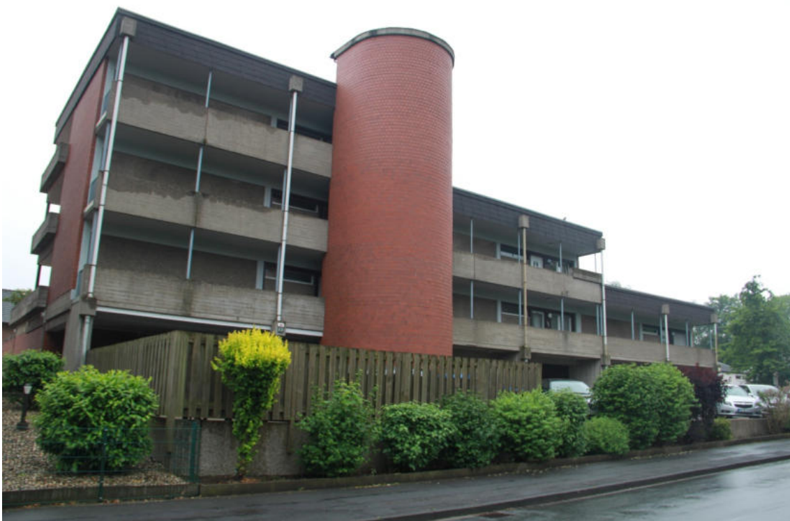
westlicher Gebäudekomplex / Ansicht von der Straße Am Röteringshof
