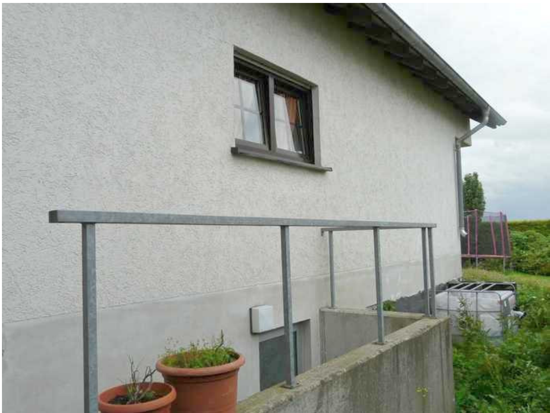
Teilansicht von Nordosten
