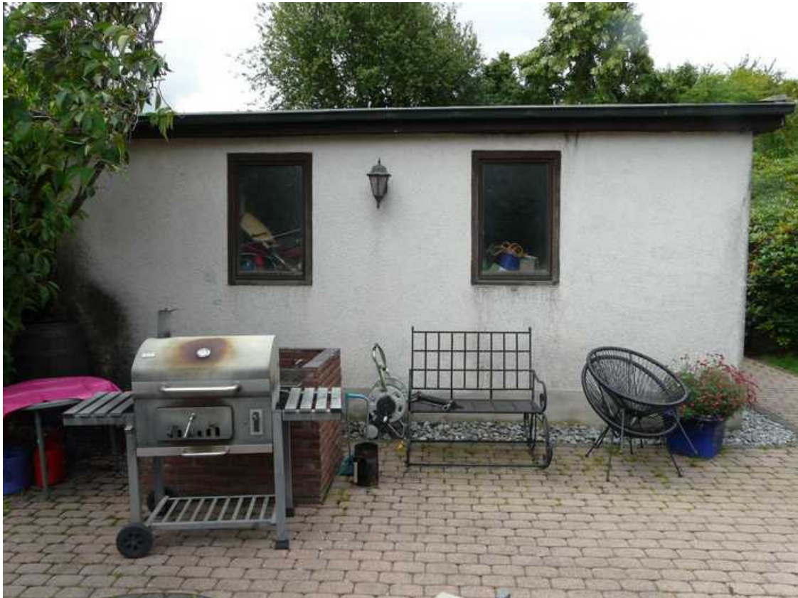
Ansicht von Norden (Doppelgarage)
