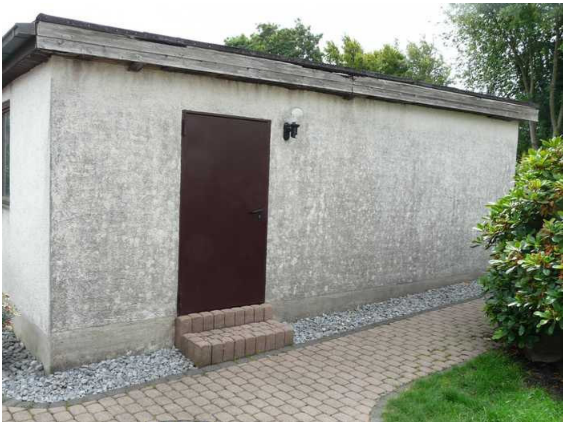
Ansicht von Westen (Doppelgarage)
