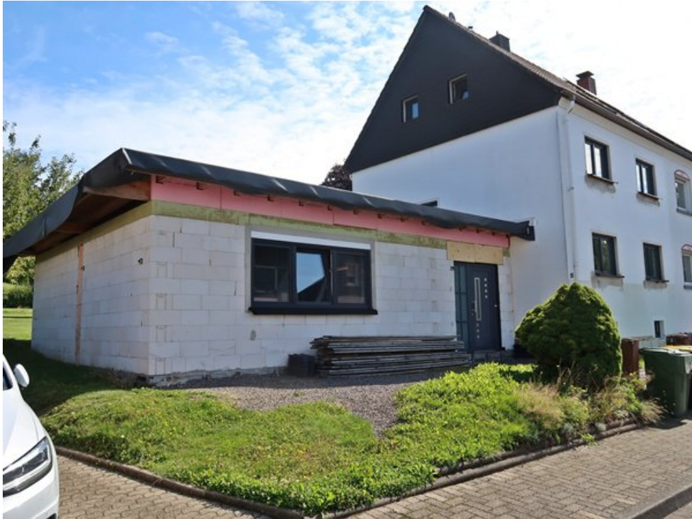
Ansicht von der Straßenseite: Anbau mit Fertigstellungsbedarf
