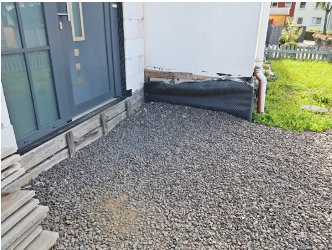
Teilansicht Hauseingangsbereich und Sockelfläche Wohnhaus
