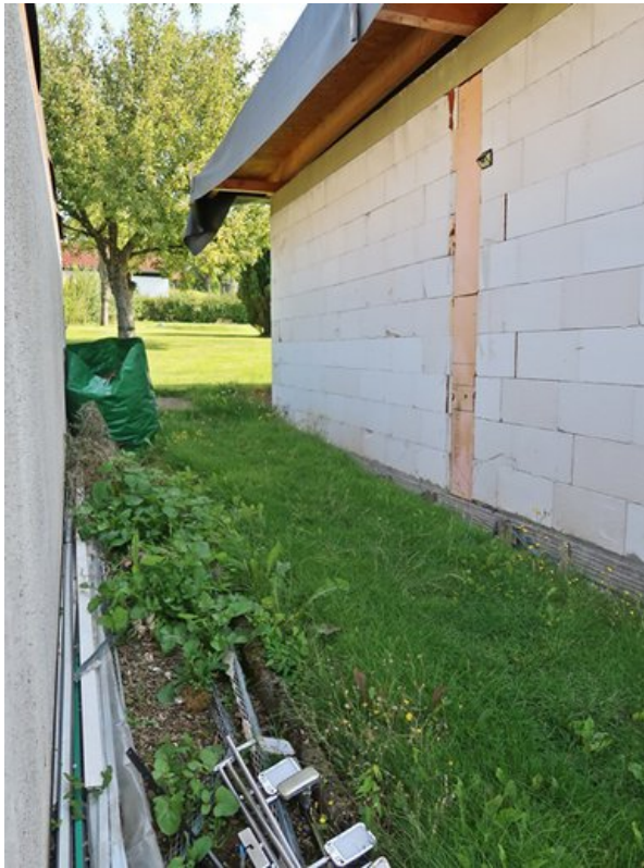
Teilansicht seitliche Außenwand
