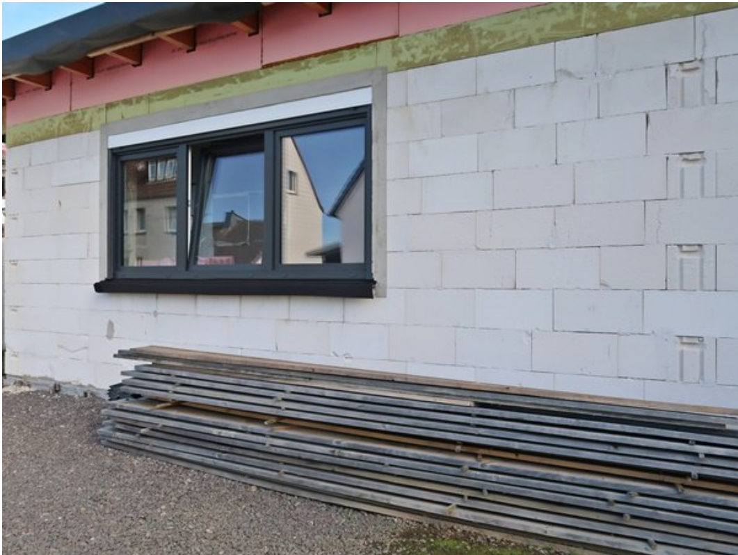
Teilansicht straßenseitige Fassadenfläche Anbau
