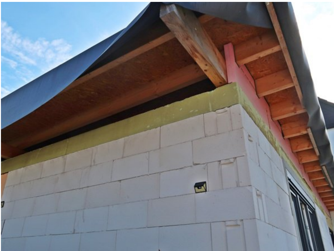
Teilansicht Außenwand – Dach
