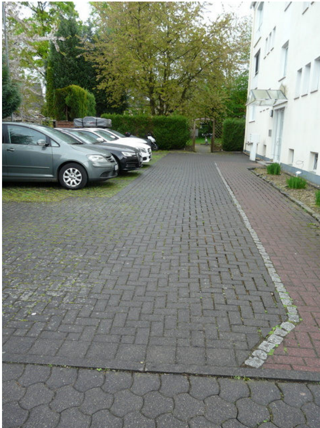
Blick in Richtung Osten
