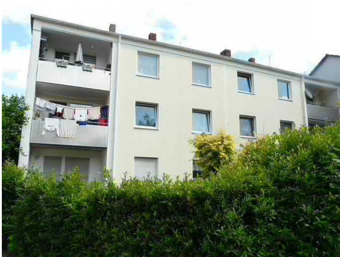
MFH Bergeder Weg 9: Ansicht von Süden
