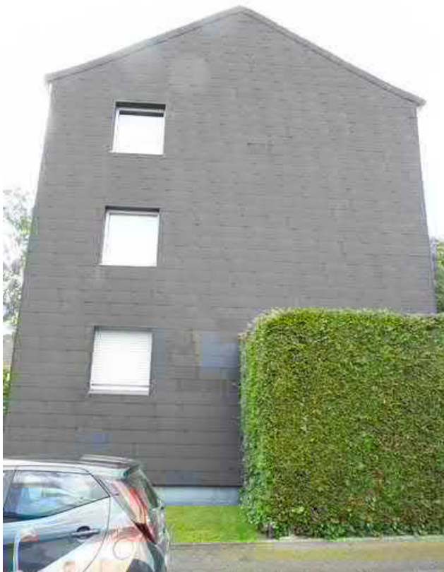
MFH Bergeder Weg 3: Ansicht von Westen
