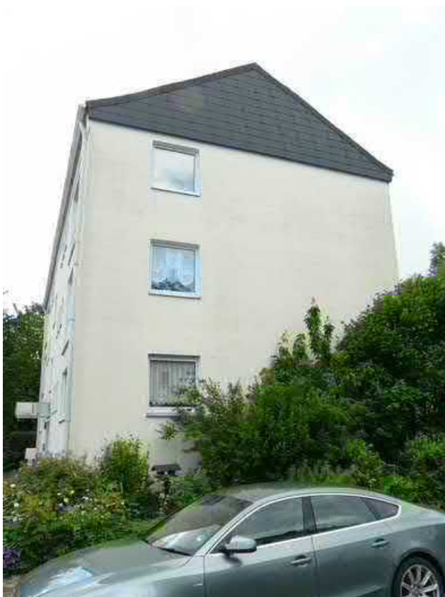
MFH Bergeder Weg 9: Ansicht von Westen
