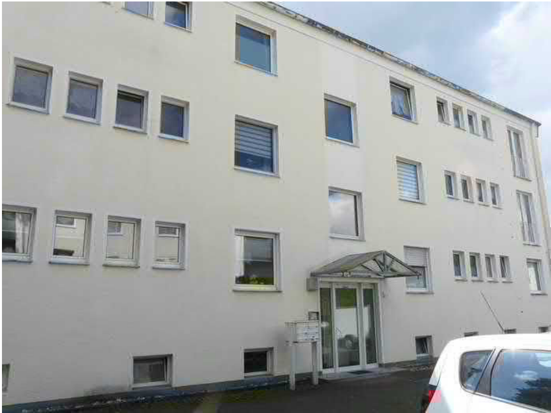
MFH Bergeder Weg 5: Ansicht von Norden
