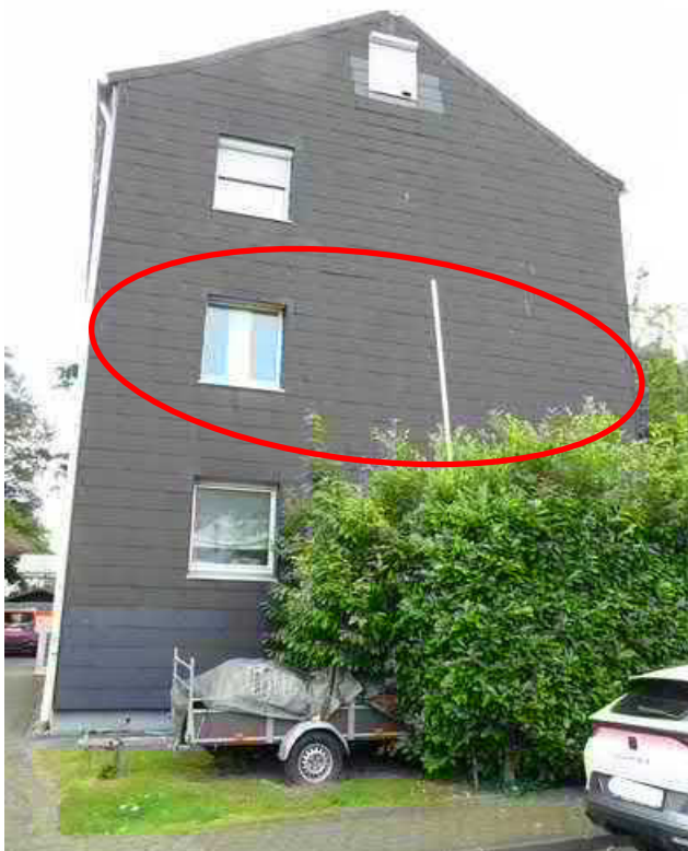
MFH Bergeder Weg 7: Ansicht von Westen
