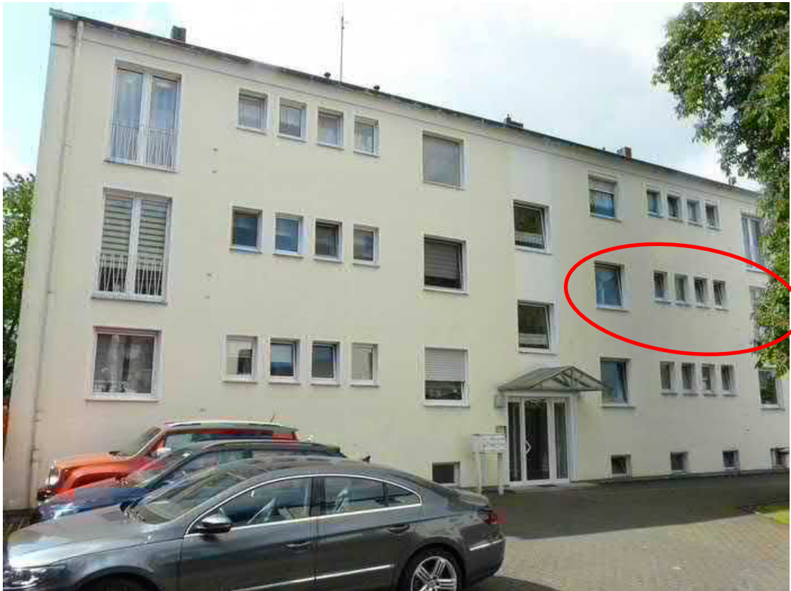
MFH Bergeder Weg 7: Ansicht von Norden
