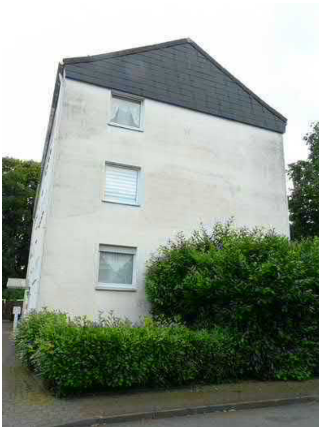
MFH Bergeder Weg 5: Ansicht von Westen
