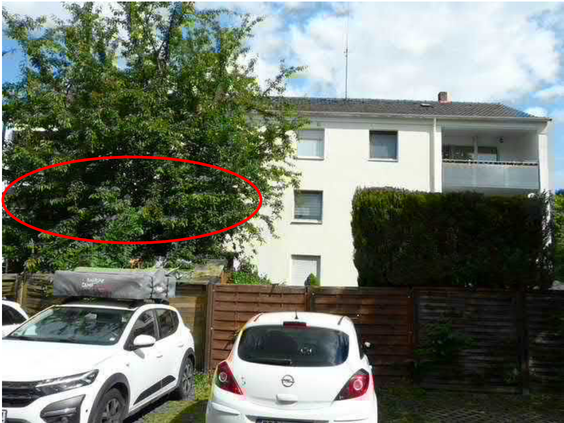
MFH Bergeder Weg 7: Ansicht von Süden
