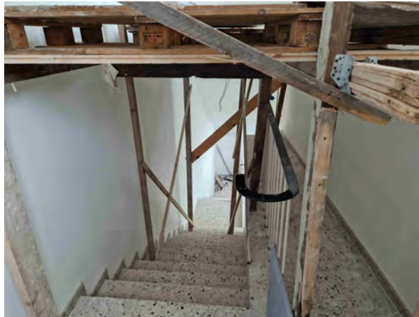
Blick in das Treppenhaus
