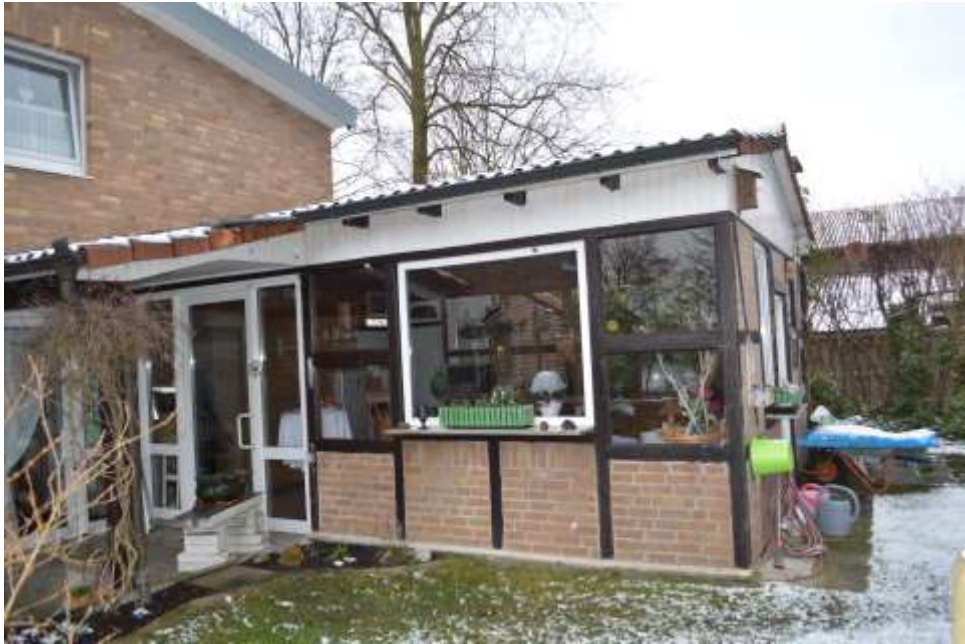
Bild 13: Wintergarten zur Betriebswohnung
