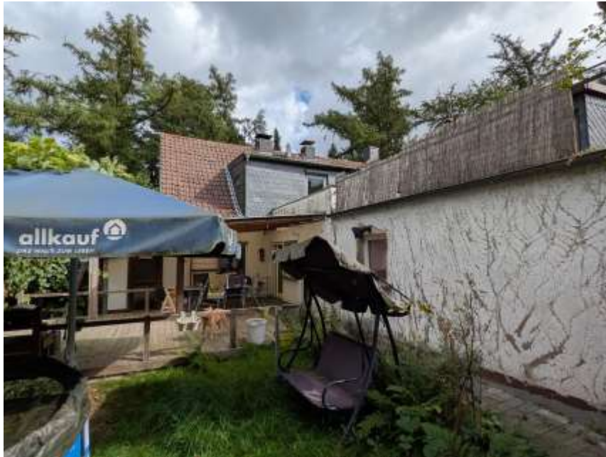
Bild 7: Westansicht Haupthaus und Anbau
