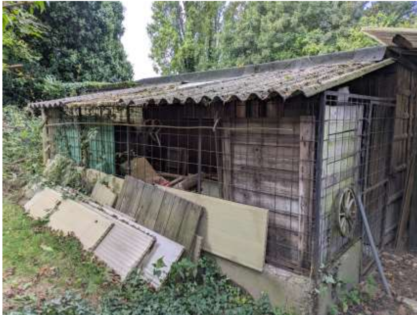
Bild 13: östlicher Anbau Garagengebäude
