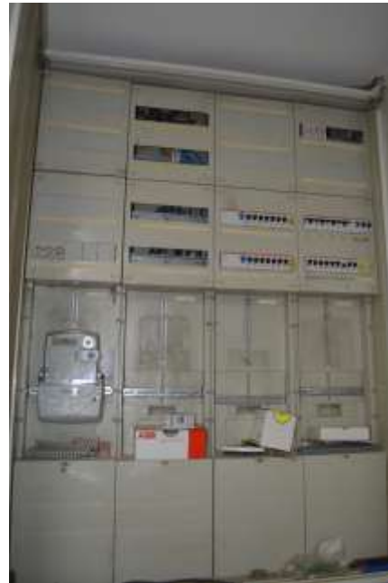
Bild 2: Elektronterverteilung Haupthaus
