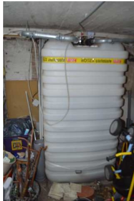
Bild 2: Heizöltank
