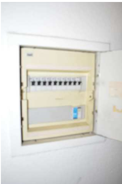
Bild 3: Beispiel Elektrounterverteilung
