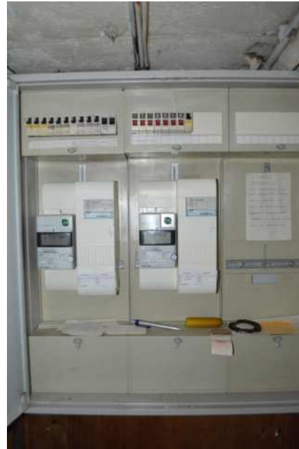
Bild 22: Elektronterverteilung
