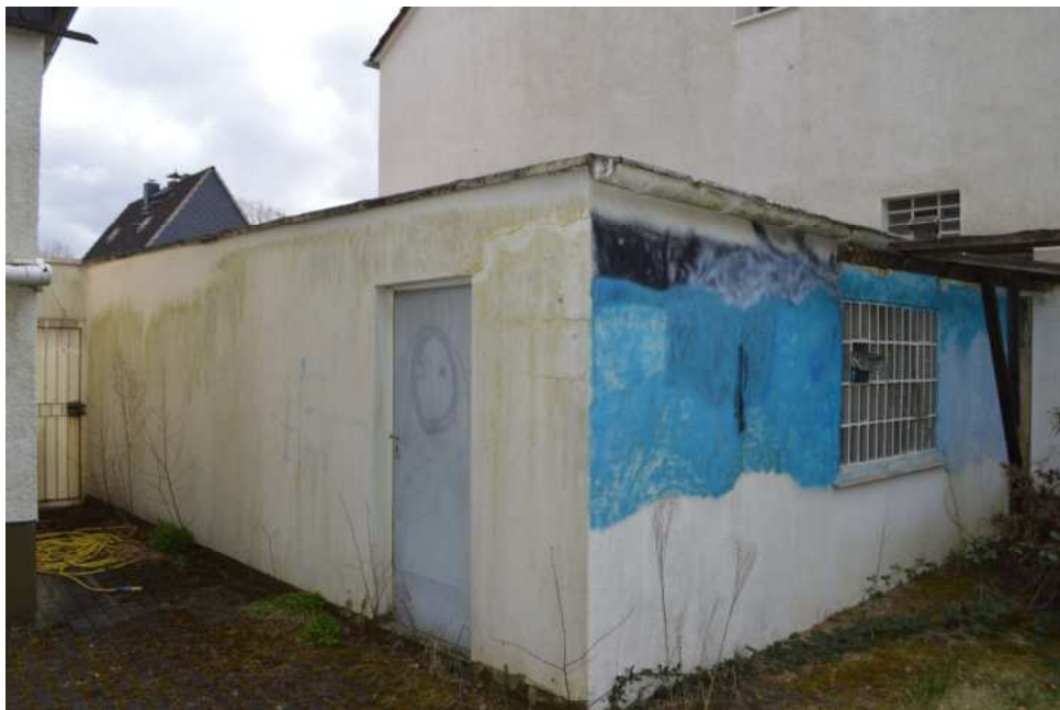
Bild 12: Seiten- / Rückansicht Garage
