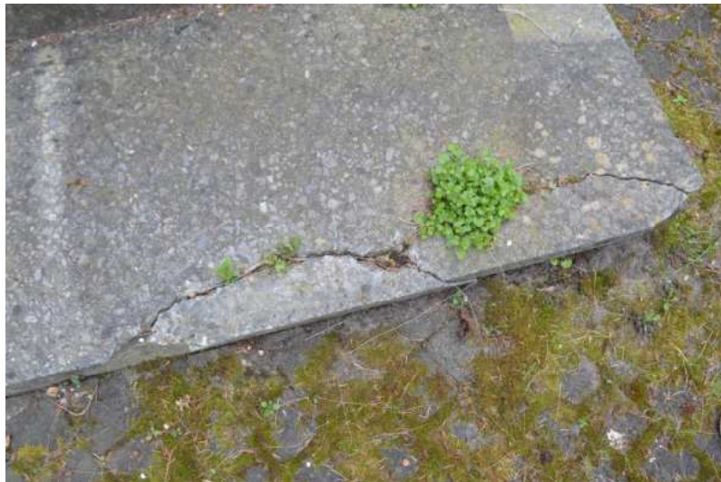
Bild 16: schadhafte Eingangsstufe
