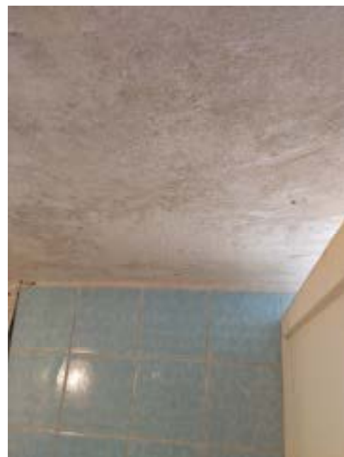
Bild 20: Feuchtigkeitsschäden Kellerdecke
