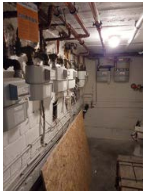
Bild 4: Gaszähler
