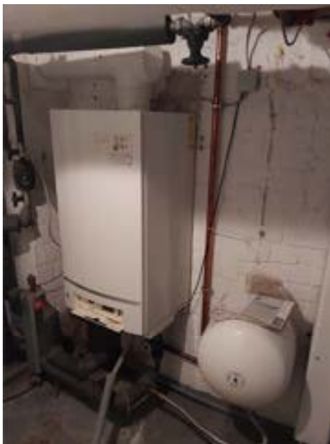
Bild 3: Gaszentralheizung
