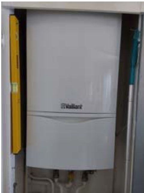
Bild 11: Bsp. Gasetagenheizung
