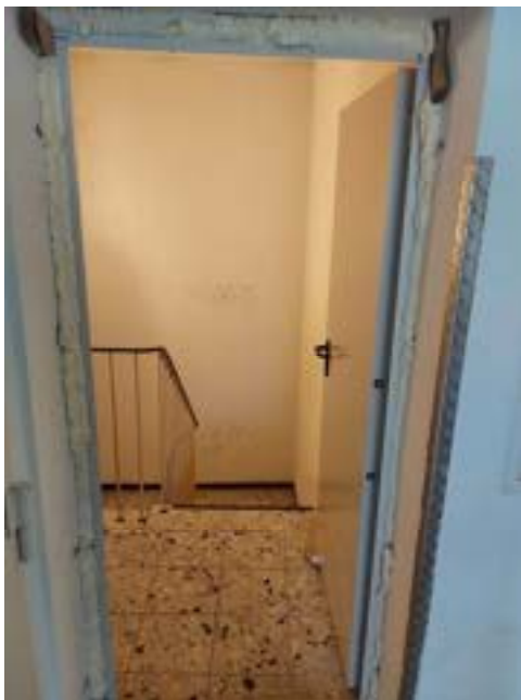
Bild 19: Treppenhaus Gewerbeinheit EG rechts
