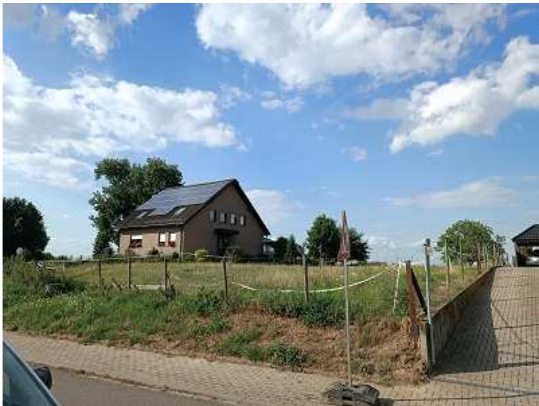
Bild 1: Straßenansicht Flurstück 44 (Blick nach Nordosten)
