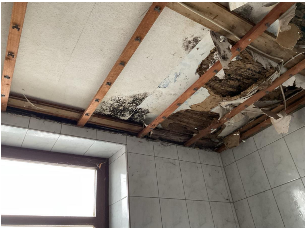
Bild 9: Erdgeschossdecke Einfamilienwohnhaus in Badezimmer
