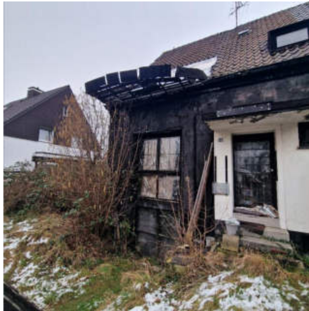
Zustand Grundstück und Gebäude von außen
