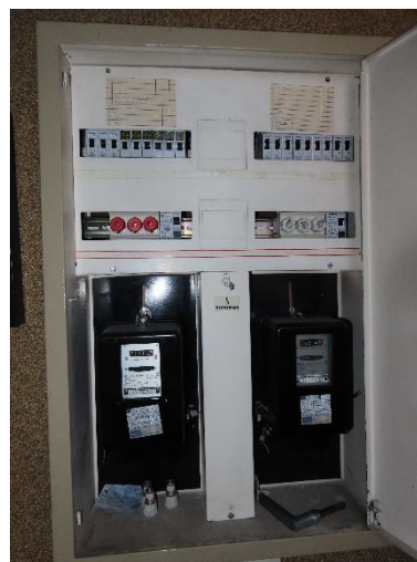
Dem sonstigen Standard des Wohnhauses entsprechend
