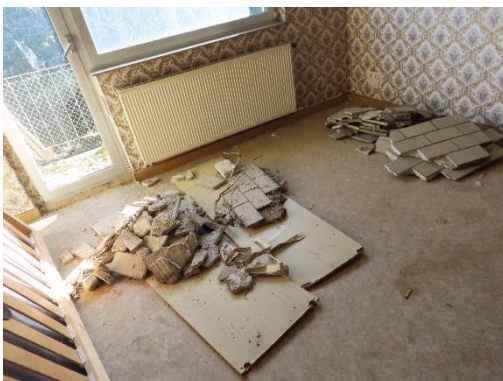
Bodenbelag in der Wohnung abgelegt
