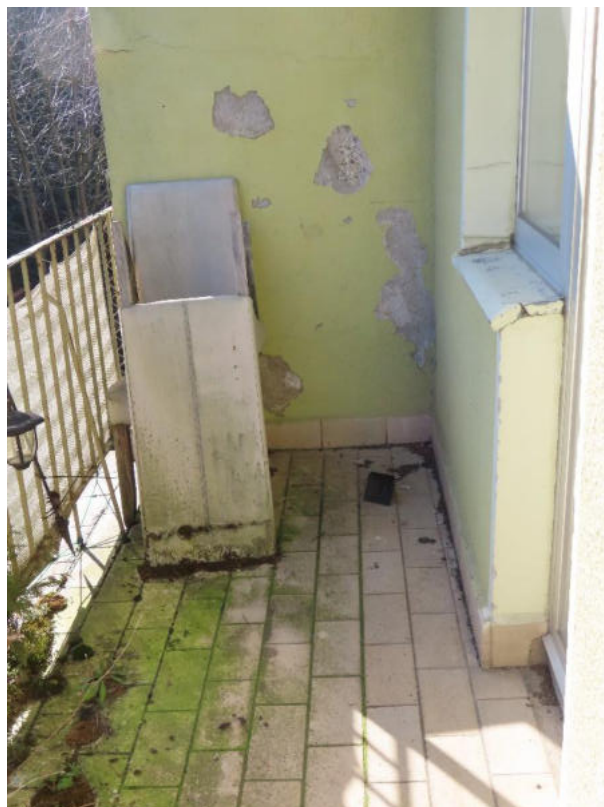
Abb. 19 + 20: WE 5- links im 2.Obergeschoss
