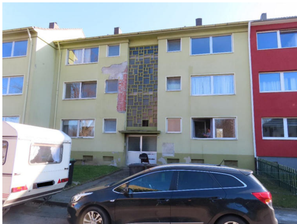
Abb. 1 + 2: Straßenansicht des Wohnhauses
