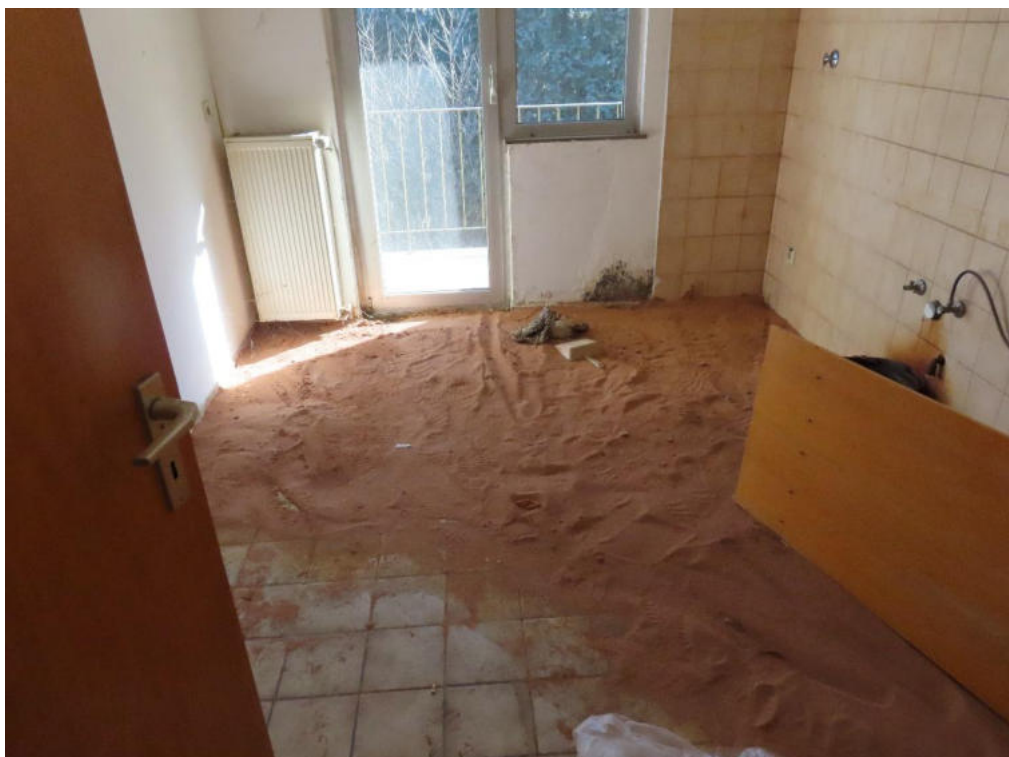
Abb. 15 + 16: WE 3- links im 1.Obergeschoss
