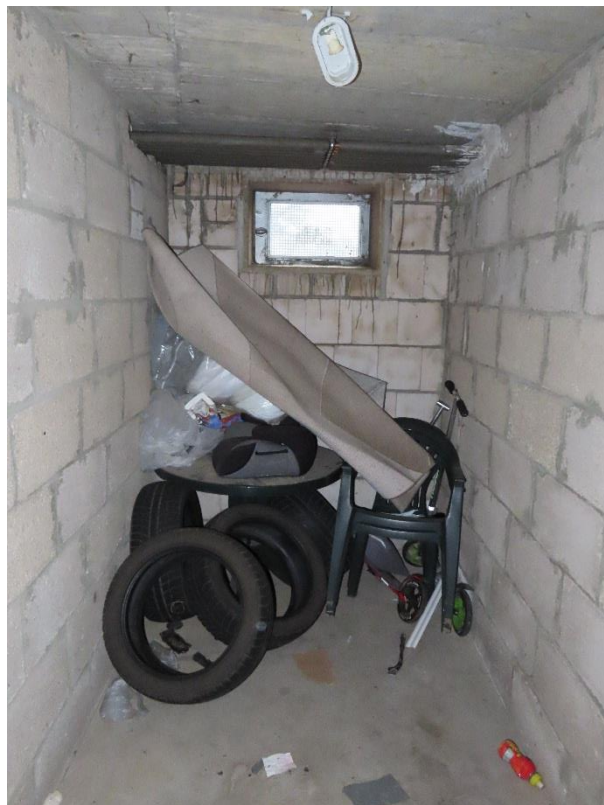
Abb. 9 + 10: Kellerflur und ein Kellerraum
