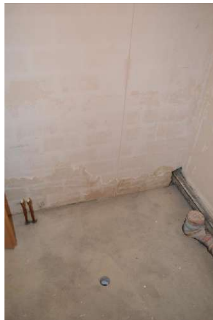
Bild 4: Feuchtigkeit Kellerbereich
