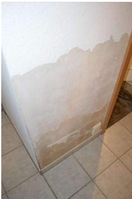
Bild 3: Feuchtigkeit Kellerbereich
