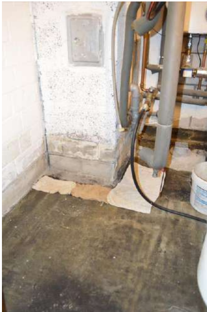
Bild 1: Feuchtigkeit Kellerbereich
