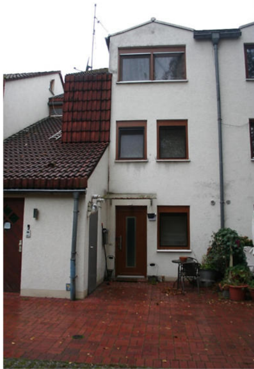
Bild 5: Vorderansicht / Ostansicht / Hauseingang
