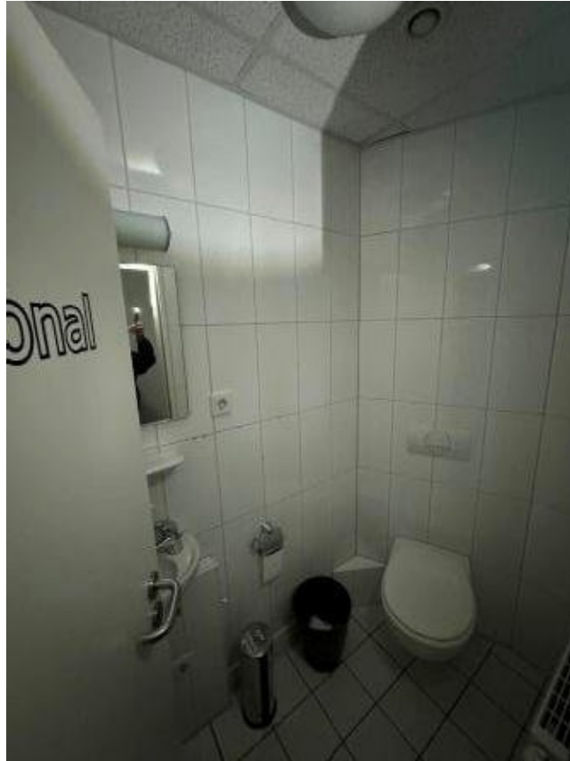
33.Foto Ansicht Bsp. WC-Raum im KG
