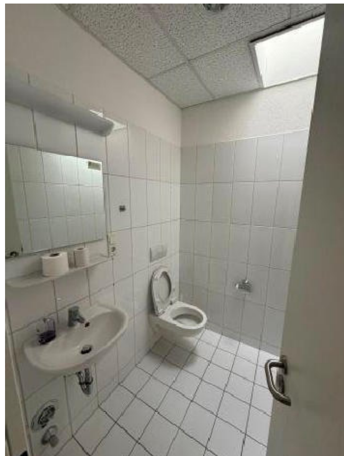
8. Foto Ansicht Bsp. Sanitärraum im 2. OG
