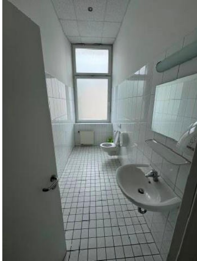
13.Foto Ansicht Damen-WC im 1. OG
